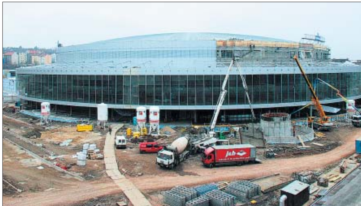
V těchto dnech se ve Vysočanech staví multifunkční aréna pro 17 000 diváků.
