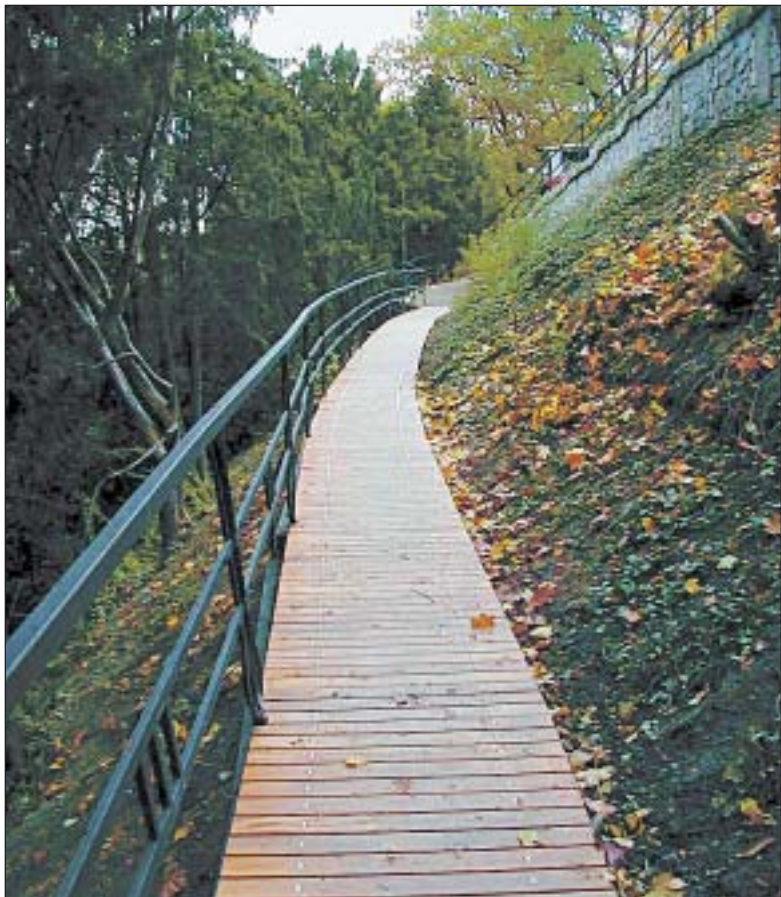
Autory cest pod Královským letohrádkem jsou ing. P. Šimek a ing. arch. Svojanovský
