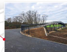
Lávka Havraňák, A4, křížení s železniční tratí
