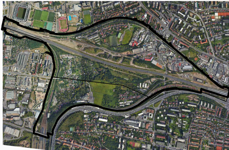
STAV - ZANEDBANÉ ÚZEMÍ Řešené území - stav Bohdalec - Slatiny, Praha 10
