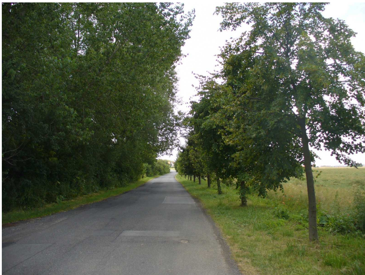
Lipanská cesta - před úpravou
