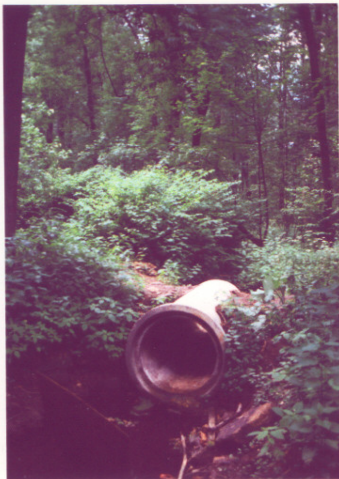
Obr. 6 Nevhodně upravená cesta ve střední části území
