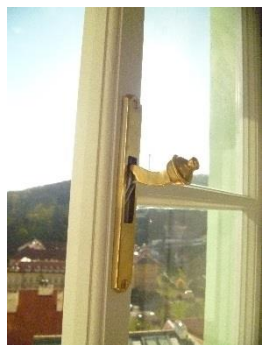
detail zrepasované kličky u okna a dveří
