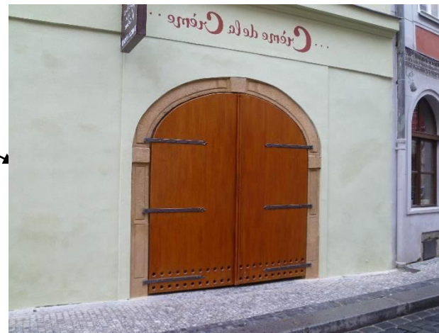
detail restaurování vstupních vrat – kovářské práce
