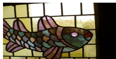
restaurování vitráží v kostele
