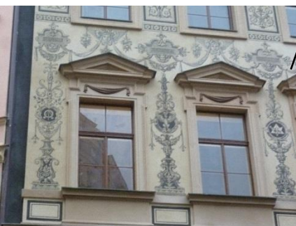
restaurování kamenného portálu
