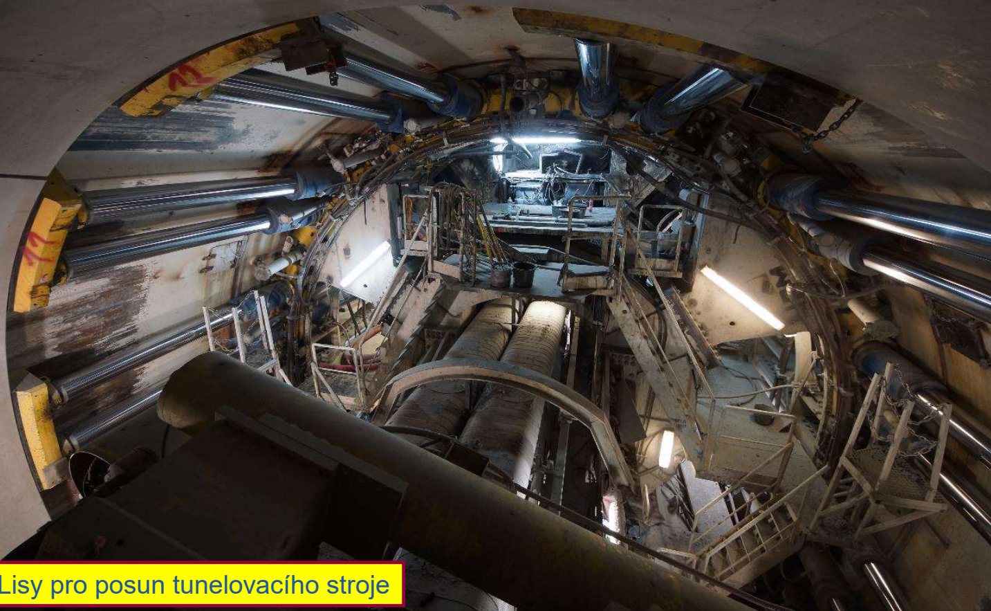
Tunely ražené tunelovacími stroji (TBM)
