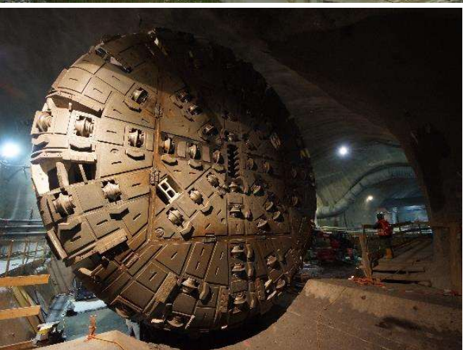
Tunelovací stroj a dopravník rubaniny
