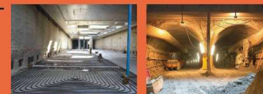
Kolektory položené do betonových základů stanic
