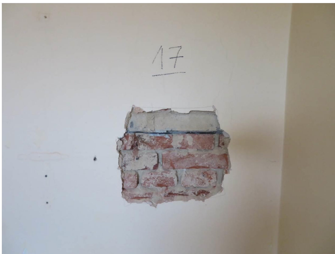
Foto 66 – Zikova 1 – 4.NP – sonda Z17 – viditelné cihly plně pálené a betonové
