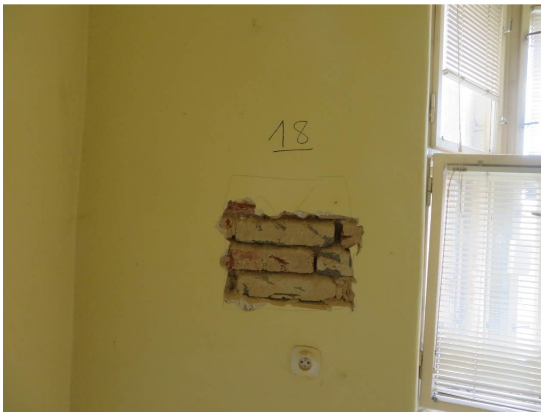
Foto 44 – Šolínova 3 – 5.NP – sonda Z18 – viditelné cihly plně pálené a betonové
