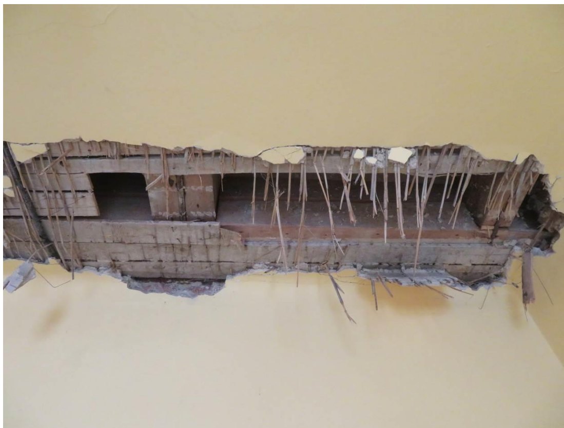
Foto 136 – Zikova 1 – 3.NP – sonda SS27 – dřevěná trémová konstrukce
