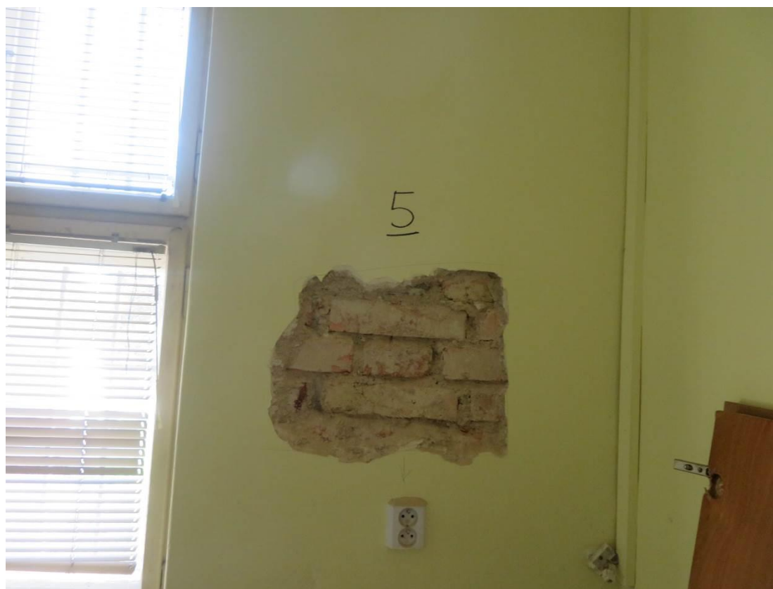
Foto 36 – Šolínova 3 – 1.NP – sonda Z5 – viditelné cihly plně pálené
