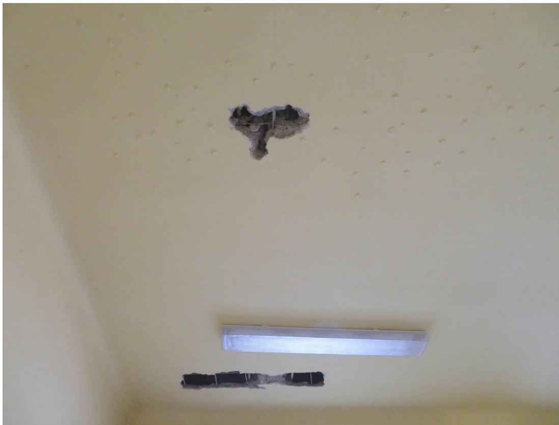
Foto 122 – Zikova 1 – 1.NP – sonda SS23/T10,D10 – sonda do stropního trámu a desky
