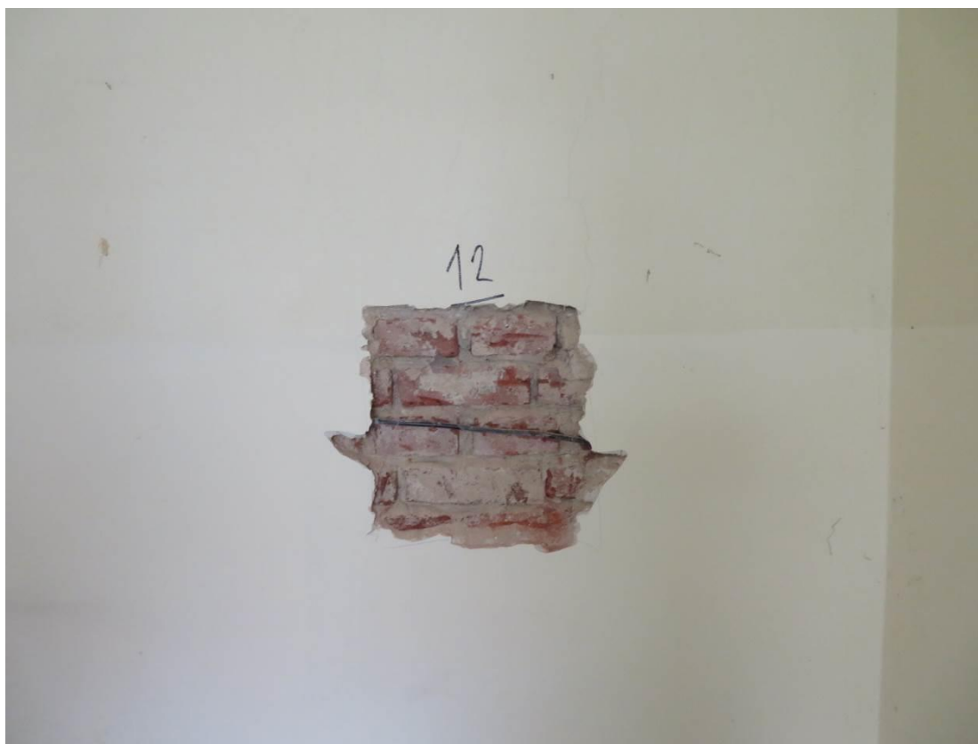
Foto 60 – Zikova 1 – 2.NP – sonda Z12 – viditelné cihly plně pálené
