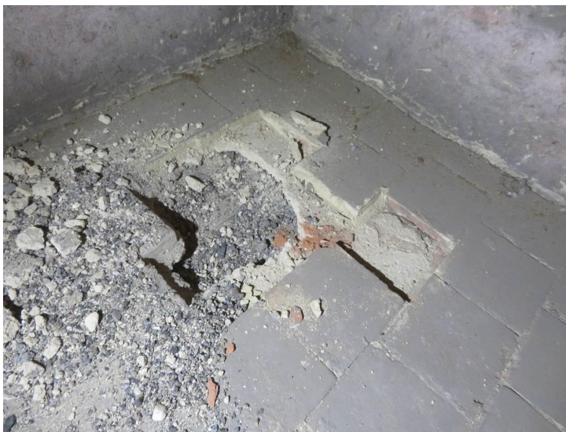
Foto 92 – Šolínova 1 – 6.NP – sonda SS10 – sonda do podlahy
