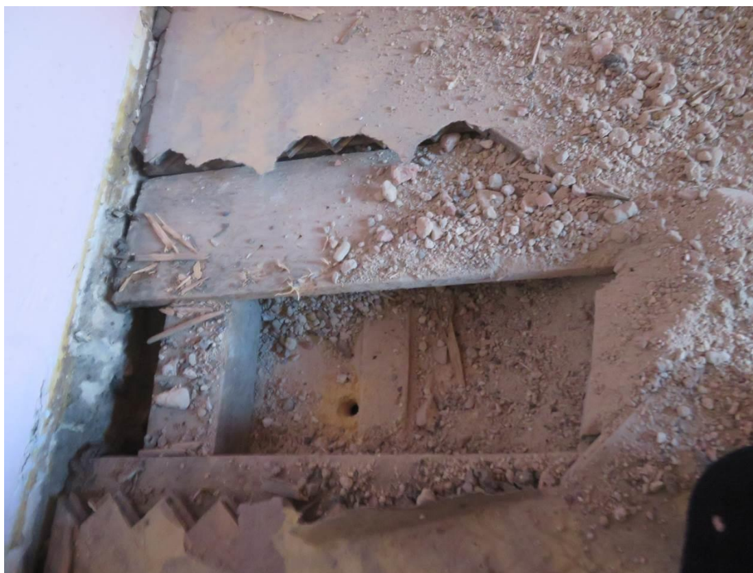
Foto 84 – Šolínova 1 – 3.NP – sonda SS6 – sonda do podlahy
