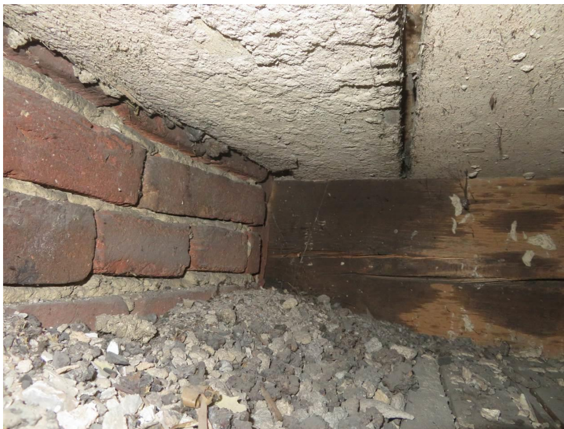
Foto 146 – Zikova 1 – 4.NP – sonda SS30 – pohled do dutiny, uložení trámu do stěny
