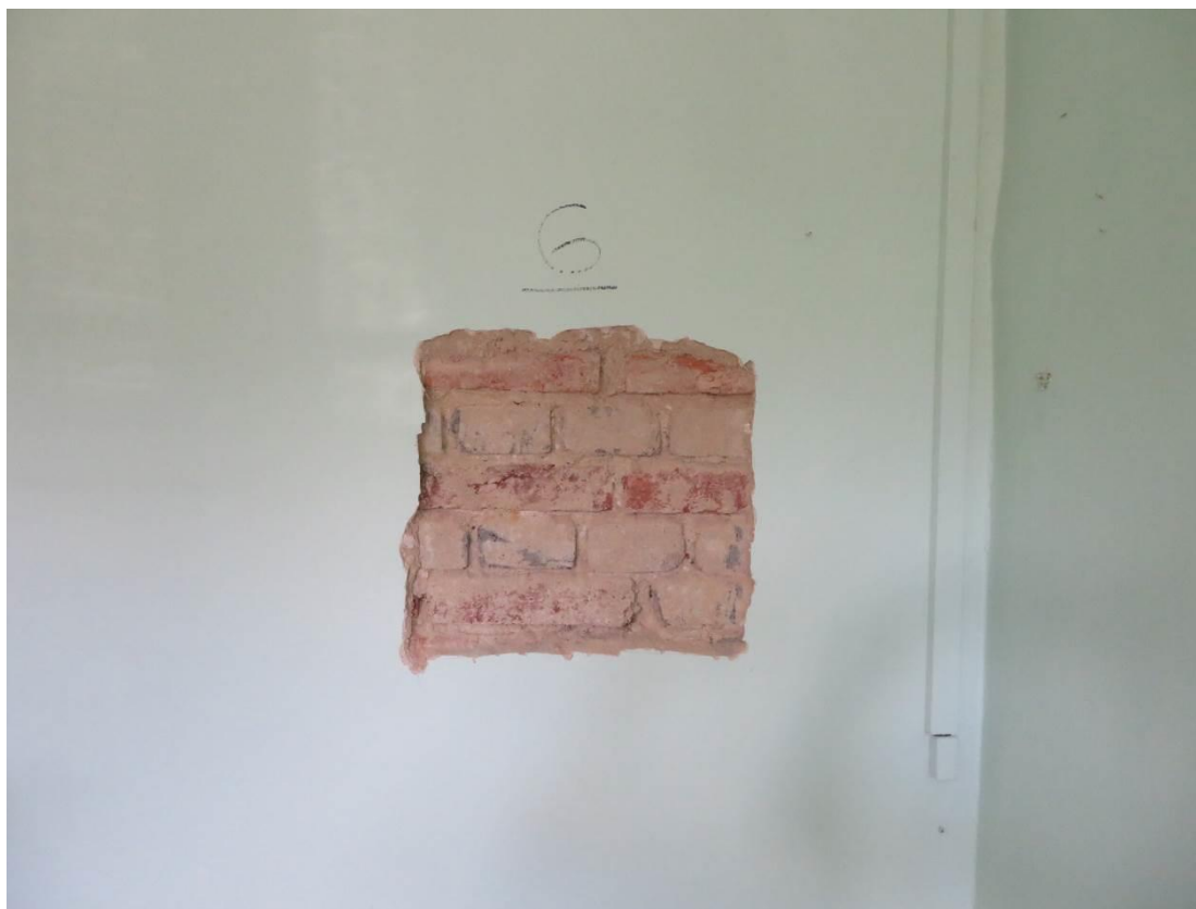
Foto 37 – Šolínova 3 – 1.NP – sonda Z5 – viditelné cihly plné pálené a betonové
