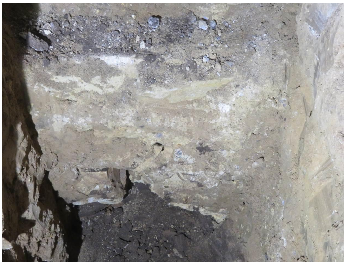
Foto 72 – Šolínova 1 – 1.PP – sonda KS1 – charakter základové konstrukce
