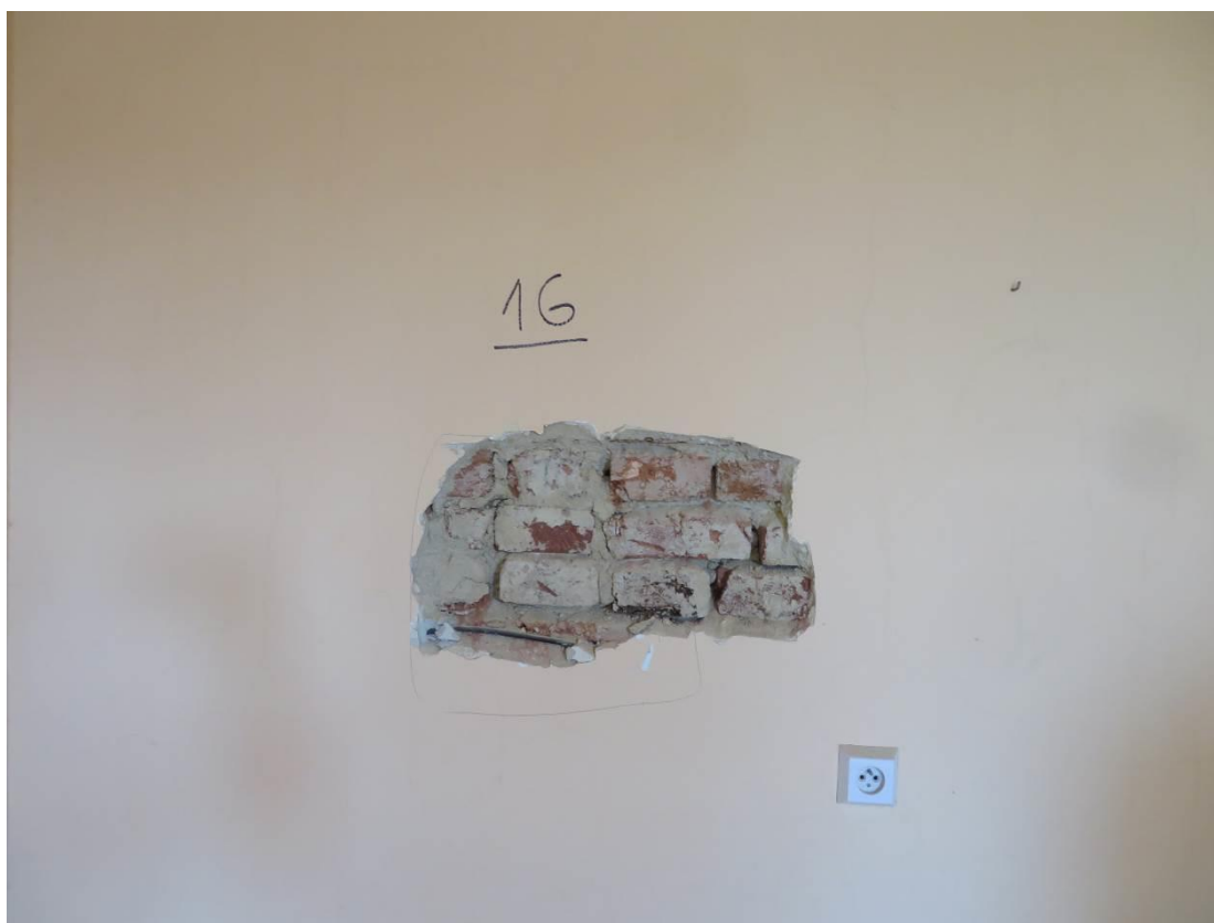
Foto 28 – Objekt Šolínova 1 – 5.NP – sonda Z16 – viditelné cihly plné pálené
