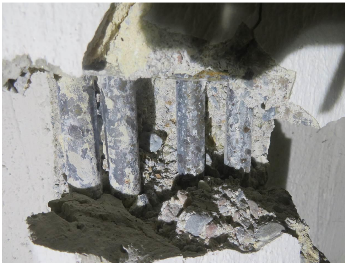
Foto 73 – Šolínova 1 – 1.PP – sonda SS1/T1,D1 – sonda do stropního trámu
