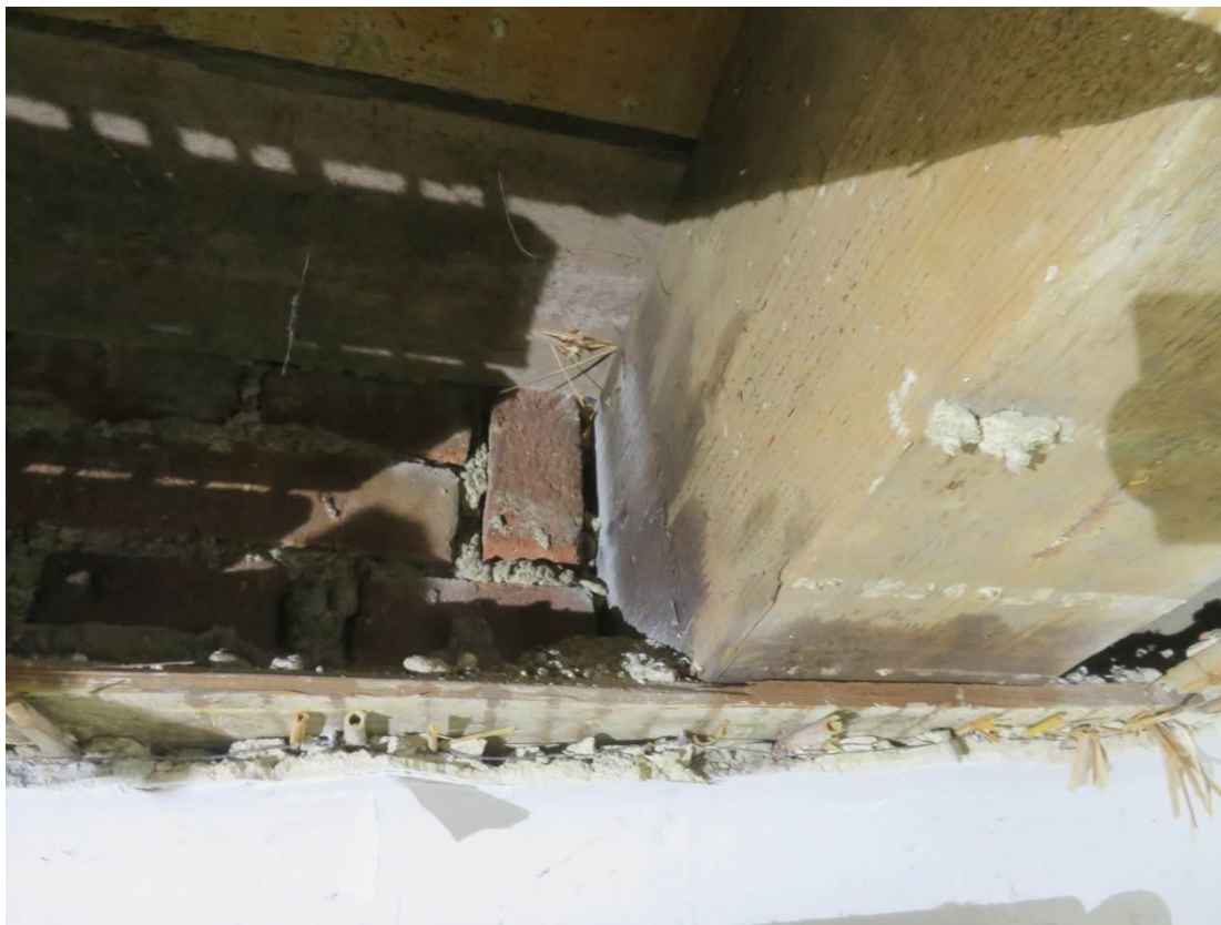
Foto 79 – Šolínova 1 – 1.NP – sonda SS3 – dřevěný trámový strop
