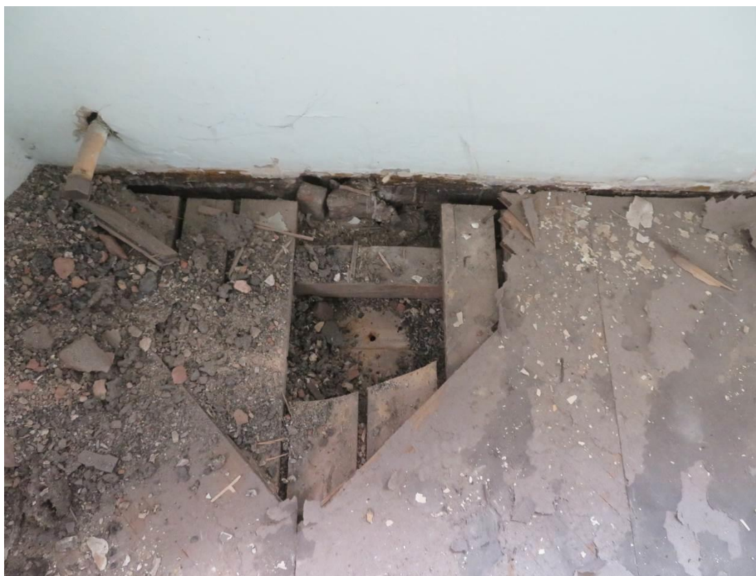
Foto 88 – Šolínova 1 – 5.NP – sonda SS8 – sonda do podlahy
