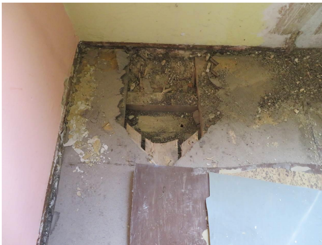
Foto 104 – Šolínova 3 – 3.NP – sonda SS15 – sonda do podlahy
