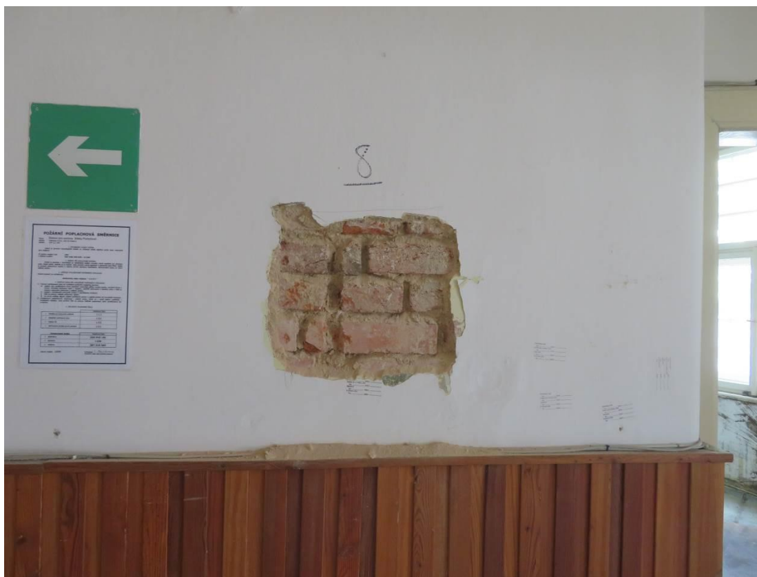
Foto 56 – Zikova 1 – 1.NP – sonda Z8 – viditelné cihly plné pálené
