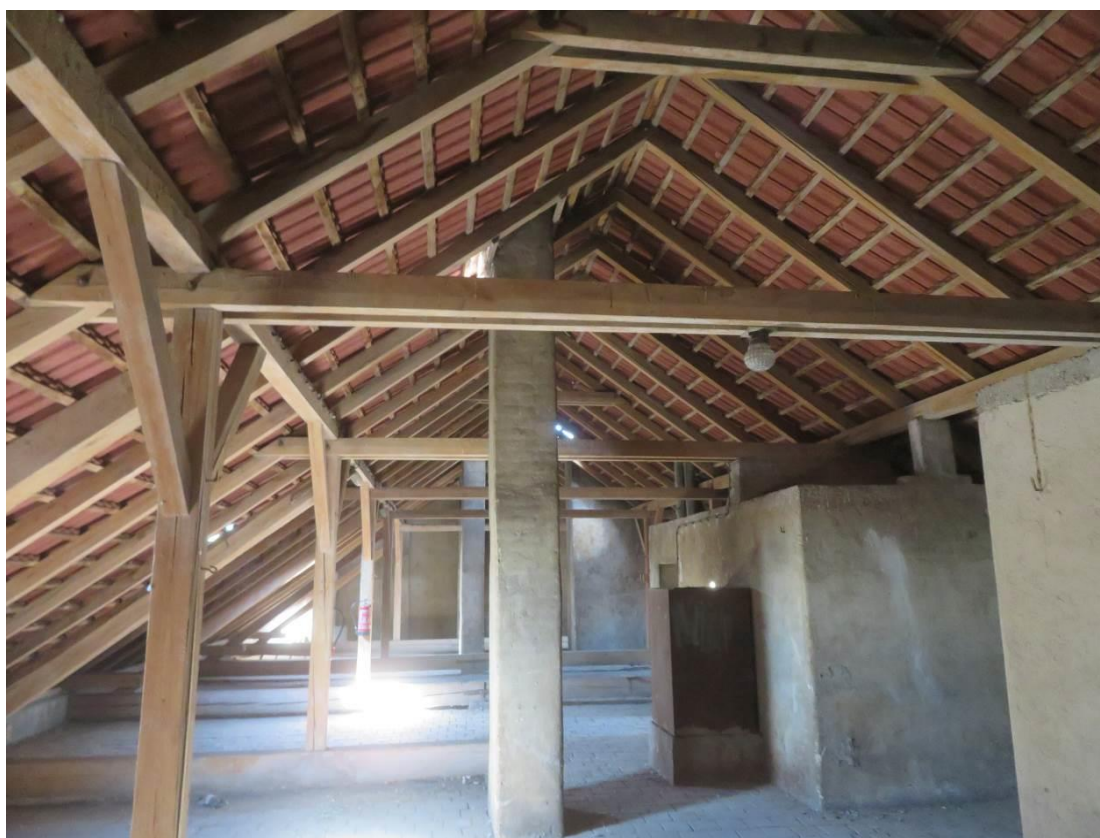
Foto 154 – Šolínova 1 – 6.NP (lokalizace v Příloze 1) – patrný charakter konstrukce krovu, nebyla zjištěna koroze dřeva ani jiné významné poruchy
