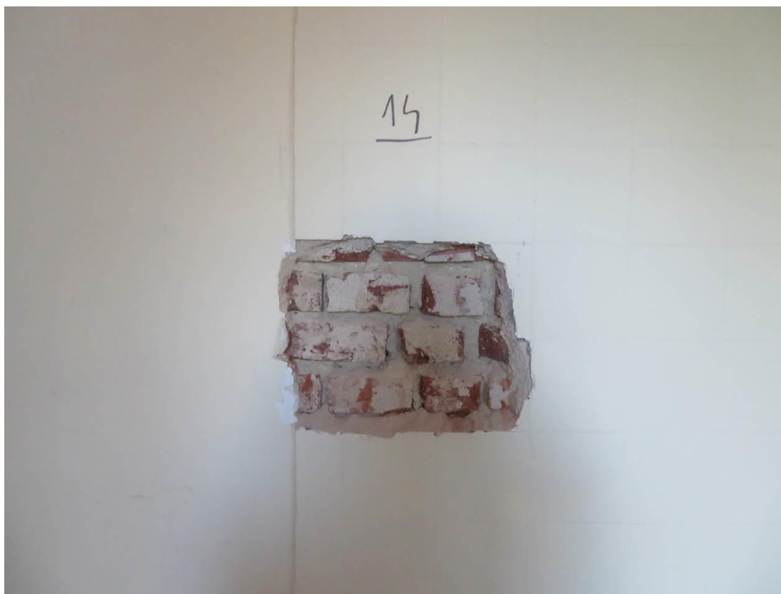
Foto 26 – Objekt Šolínova 1 – 5.NP – sonda Z14 – viditelné cihly plné pálené
