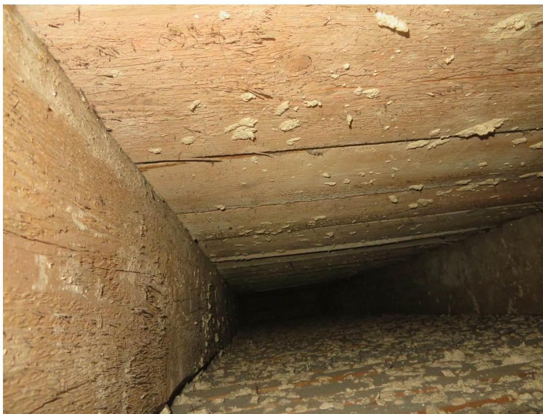
Foto 141 – Zikova 1 – 4.NP – sonda SS29 – pohled do dutiny
