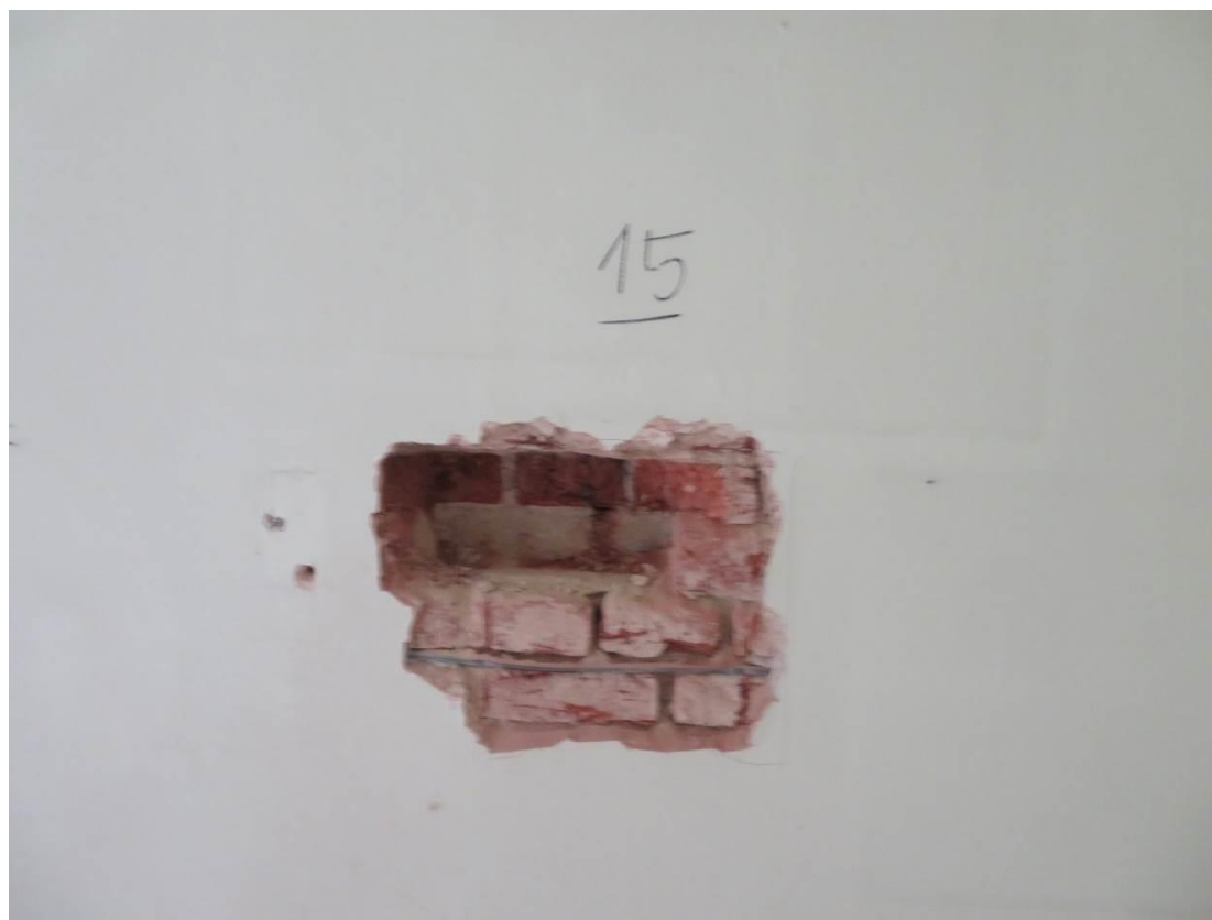
Foto 62 – Zikova 1 – 3.NP – sonda Z15 – viditelné cihly plné pálené
