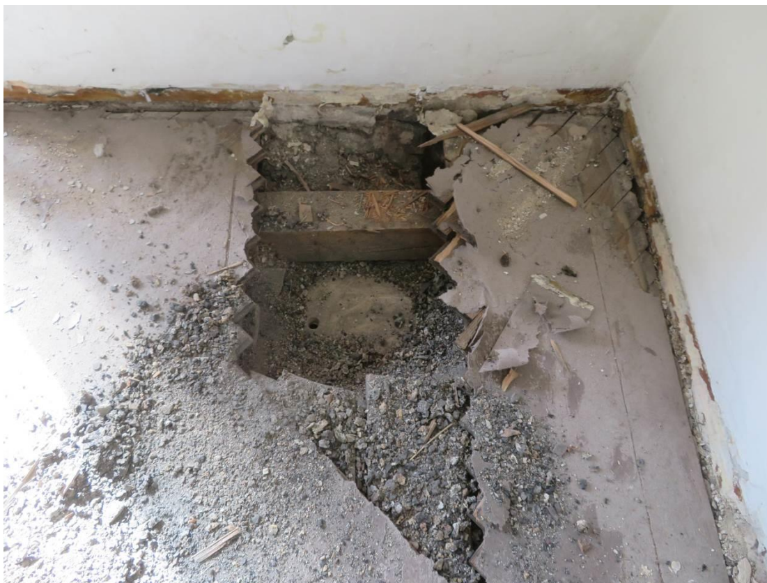
Foto 86 – Šolínova 1 – 4.NP – sonda SS7 – sonda do podlahy
