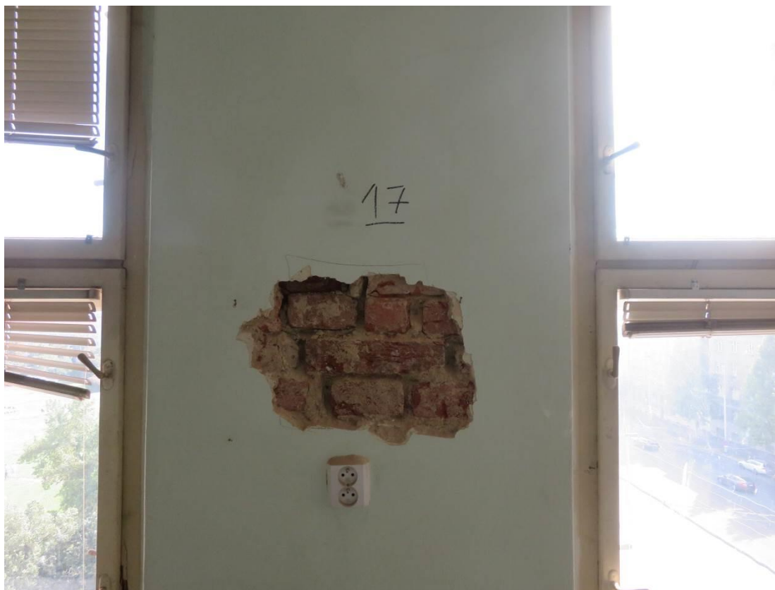
Foto 29 – Objekt Šolínova 1 – 5.NP – sonda Z17 – viditelné cihly plně pálené
