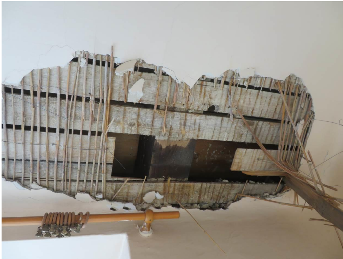
Foto 85 – Šolínova 1 – 3.NP – sonda SS7 – dřevěný trámový strop
