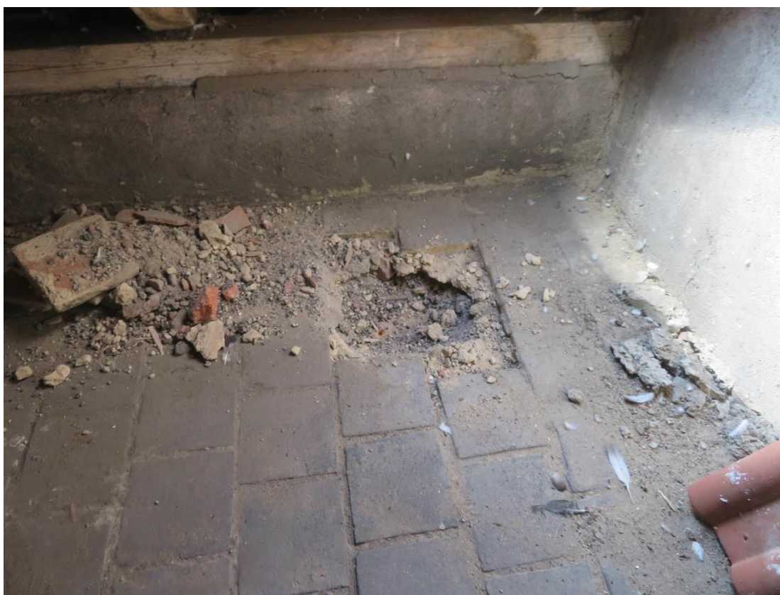
Foto 90 – Šolínova 1 – 6.NP – sonda SS9 – sonda do podlahy
