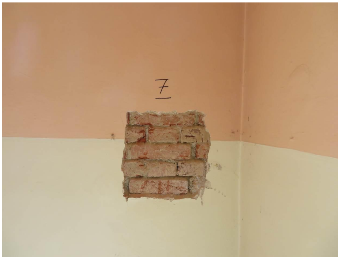
Foto 23 – Objekt Šolínova 1 – 2.NP – sonda Z7 – viditelné cihly plné pálené
