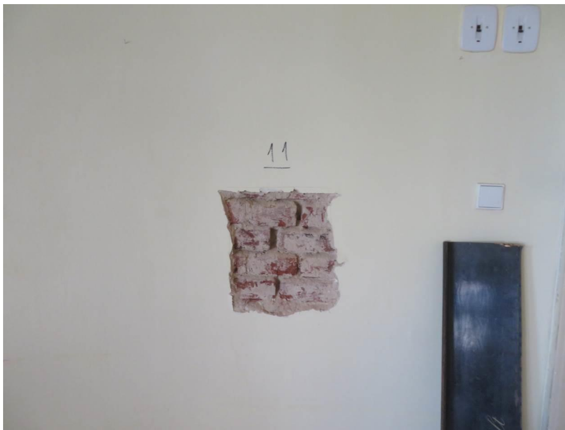
Foto 59 – Zikova 1 – 2.NP – sonda Z11 – viditelné cihly plně pálené
