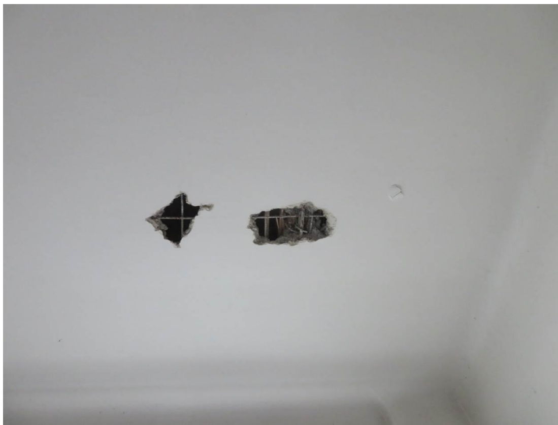
Foto 126 – Zikova 1 – 1.NP – sonda SS24/T11,D11 – sonda do stropního trámu, viditelné vyztužení podhledu
