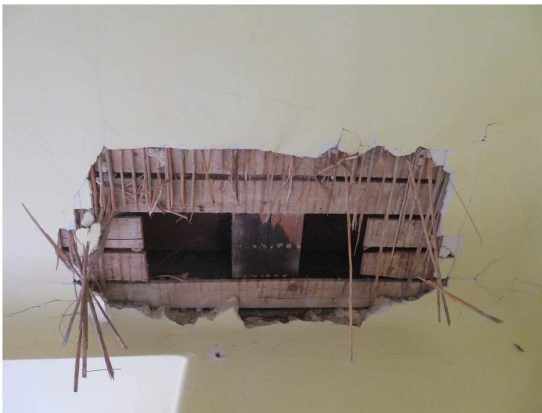
Foto 108 – Šolínova 3 – 3.NP – sonda SS17 – dřevěný trámový strop
