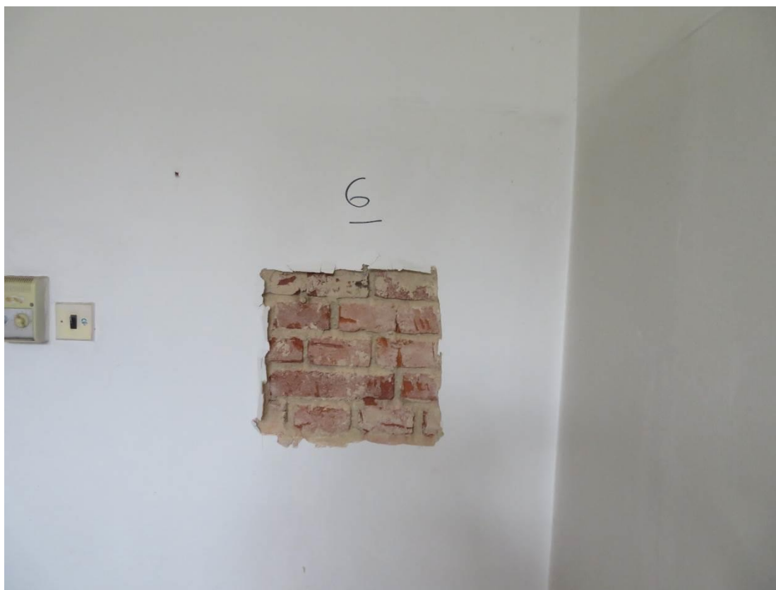
Foto 54 – Zikova 1 – 1.NP – sonda Z6 – viditelné cihly plně pálené
