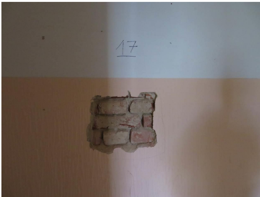
Foto 43 – Šolínova 3 – 5.NP – sonda Z17 – viditelné cihly plně pálené
