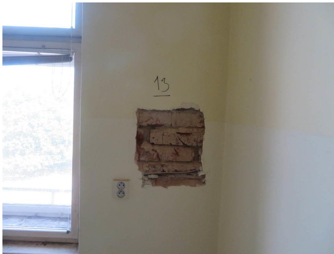
Foto 61 – Zikova 1 – 2.NP – sonda Z13 – viditelné cihly plné pálené
