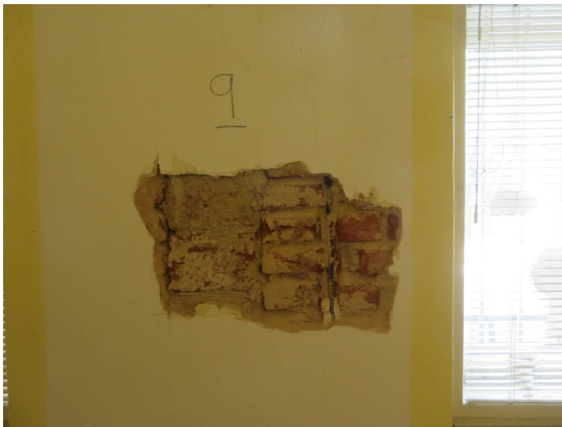
Foto 57 – Zikova 1 – 1.NP – sonda Z9 – viditelné cihly plné pálené a betonové
