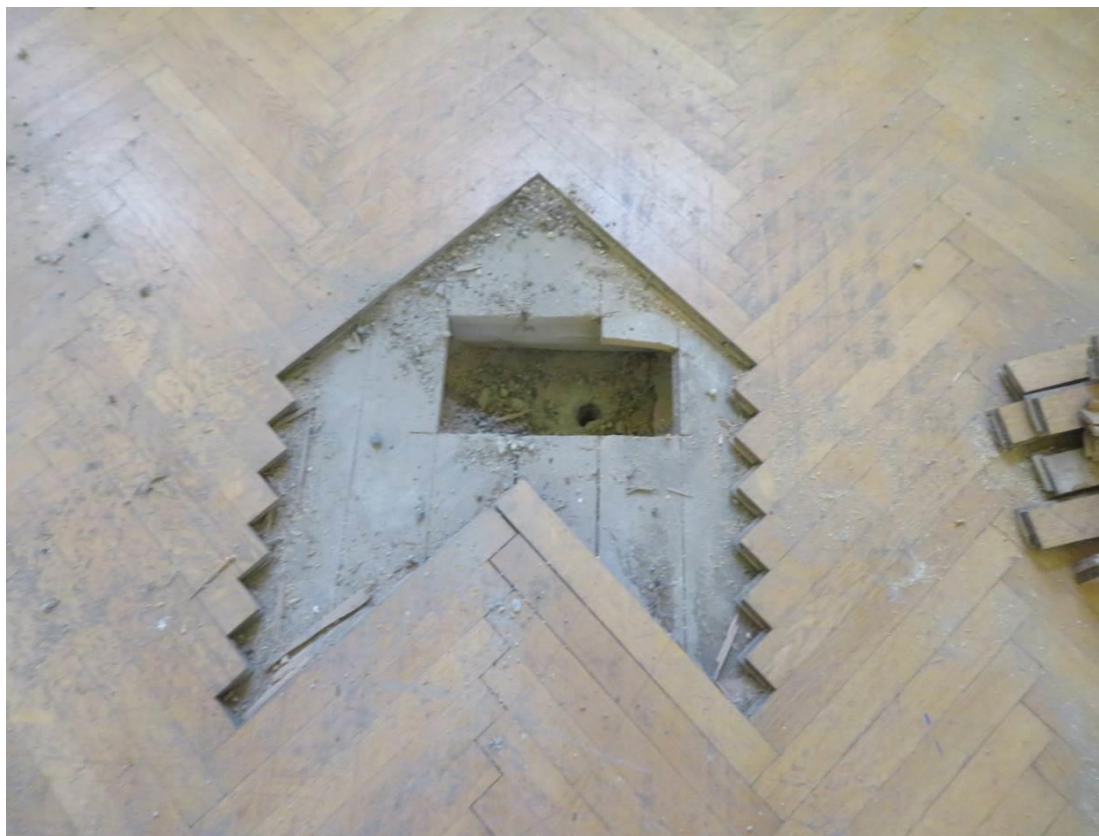
Foto 119 – Zikova 1 – 1.NP – sonda SS21/D8 – sonda do podlahy
