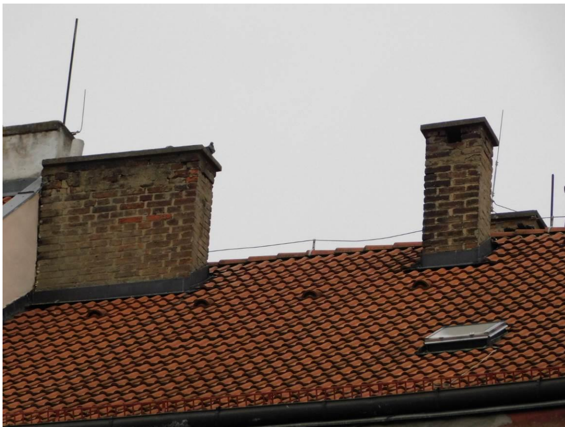
Foto 2 – Celkový pohled na objekt v ul. Šolínova 1 – pohled z ulice Evropská – detail střešní krytiny bez viditelných poruch
