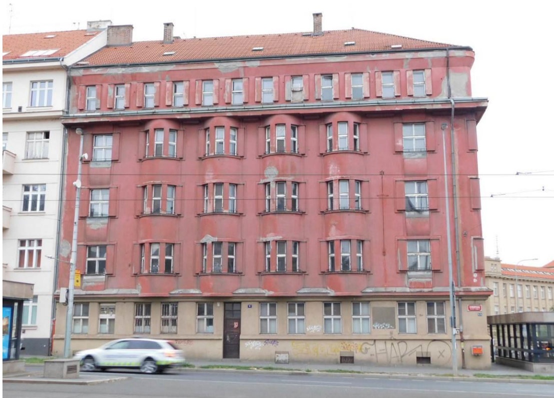
Foto 1 – Celkový pohled na objekt v ul. Šolínova 1 – pohled z ulice Evropská – viditelné pouze lokální opravy fasády
