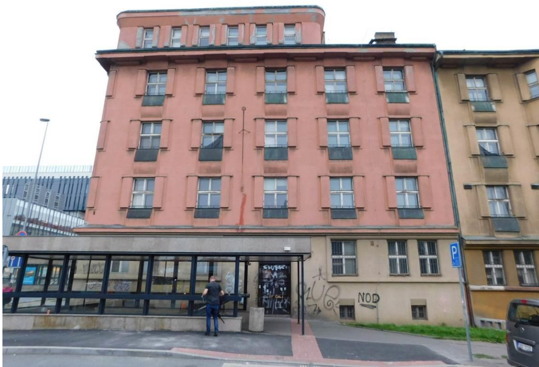
Foto 4 – Celkový pohled na objekt v ul. Šolínova 1 – pohled z ulice Šolínova – viditelné pouze lokální opravy fasády
