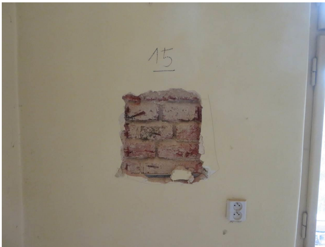
Foto 41 – Šolínova 3 – 4.NP – sonda Z15 – viditelné cihly plně pálené
