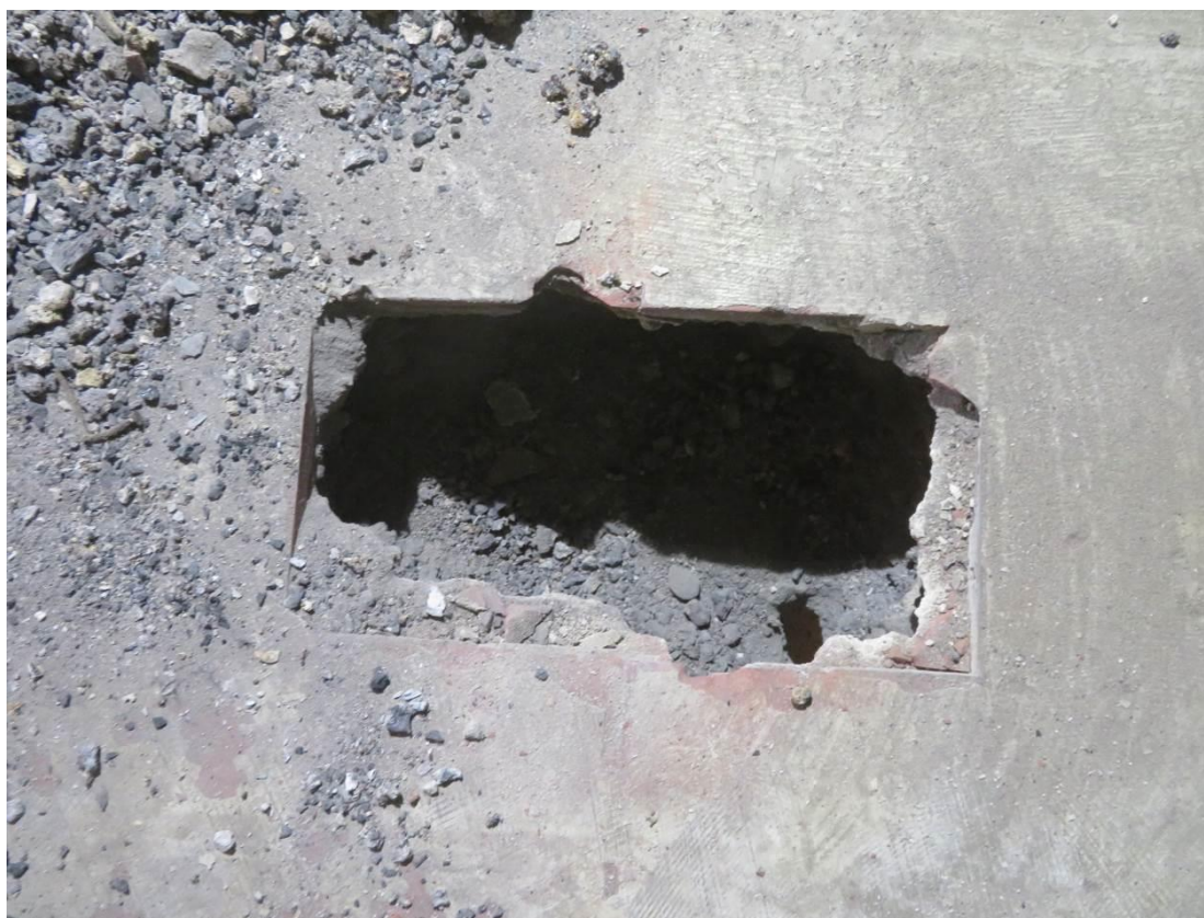
Foto 82 – Šolínova 1 – 3.NP – sonda SS5/D3 – sonda do podlahy
