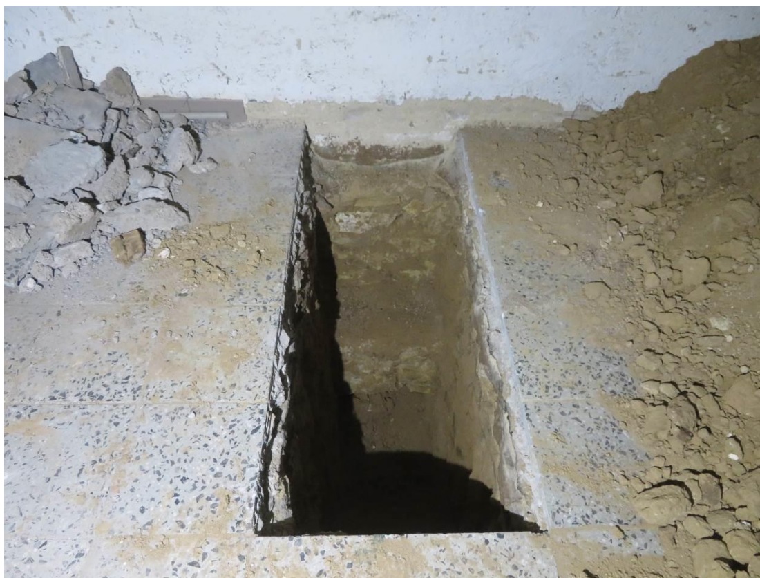
Foto 93 – Šolínova 3 – 1.PP – sonda KS2 – charakter základové konstrukce
