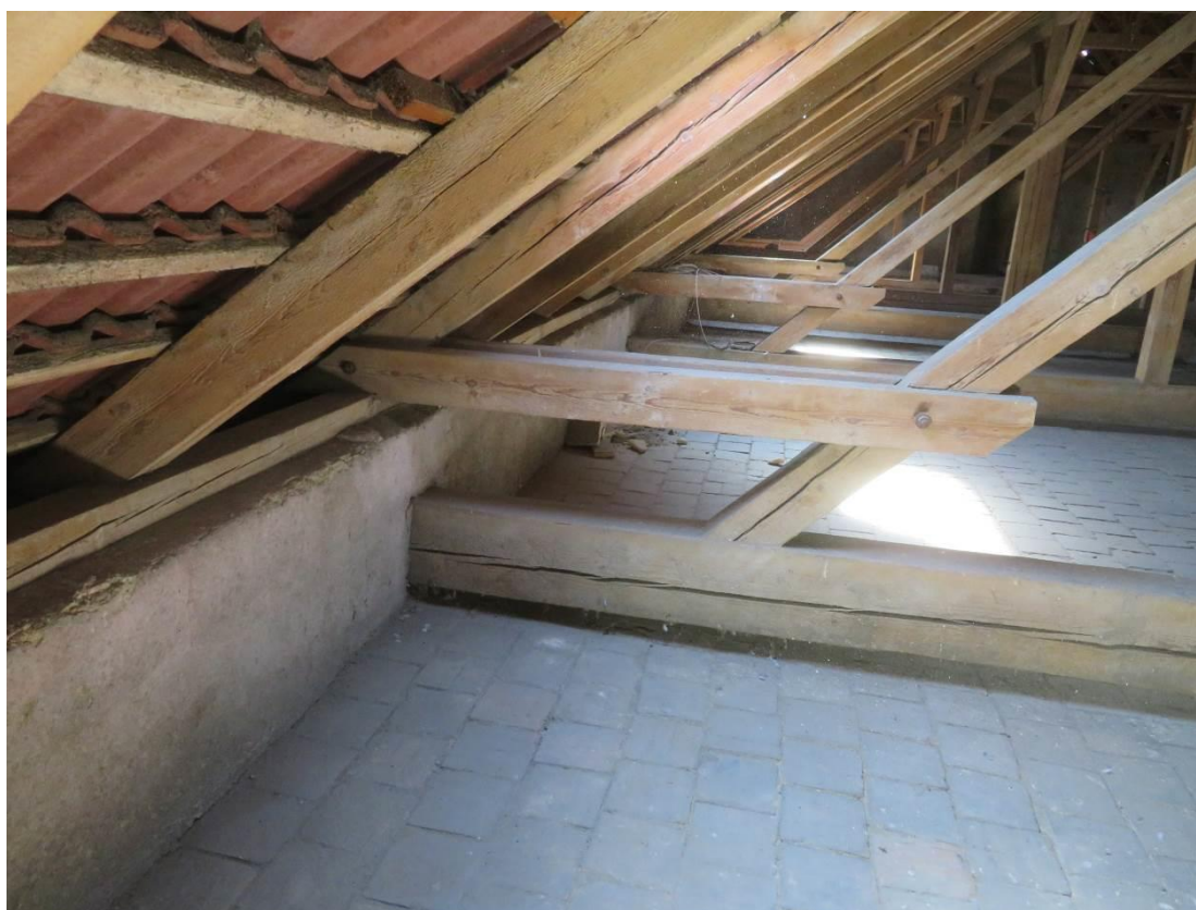
Foto 164 – Šolínova 3 – 5.NP (lokalizace v Příloze 1) – patrný charakter konstrukce krovu, nebyla zjištěna koroze dřeva ani jiné významné poruchy
