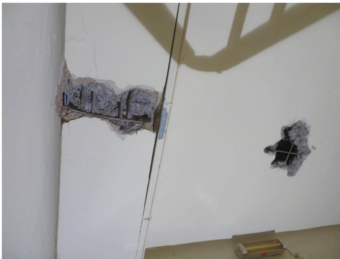
Foto 100 – Šolínova 3 – 1.NP – sonda SS13/T6,D6 – sonda do stropního trámu
