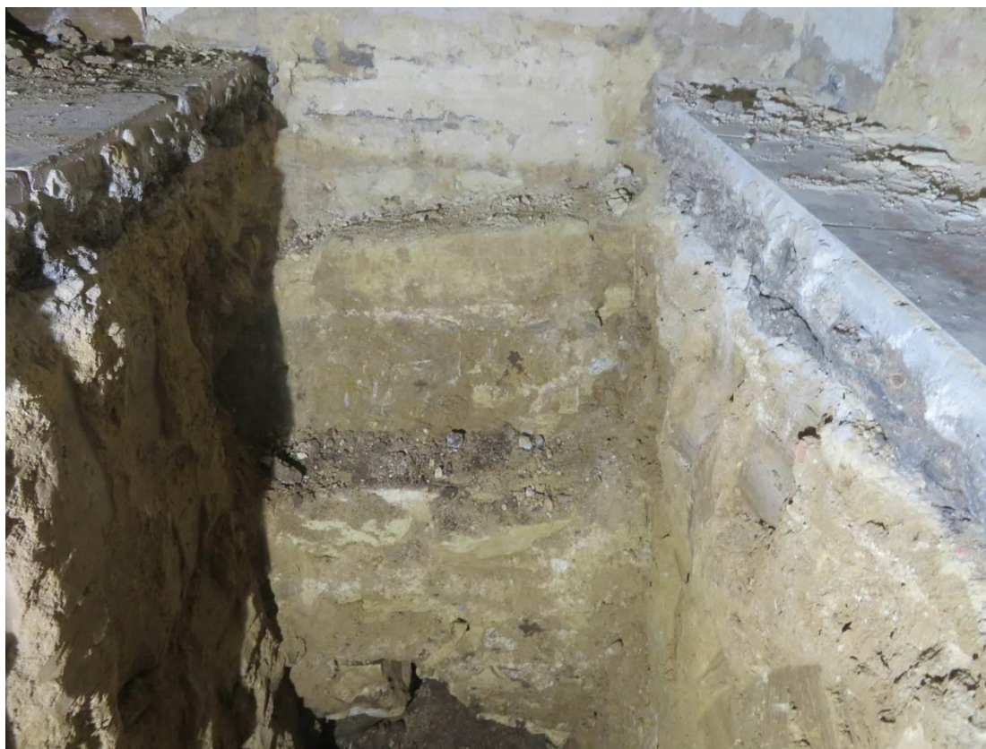
Foto 71 – Šolínova 1 – 1.PP – sonda KS1 – charakter základové konstrukce
