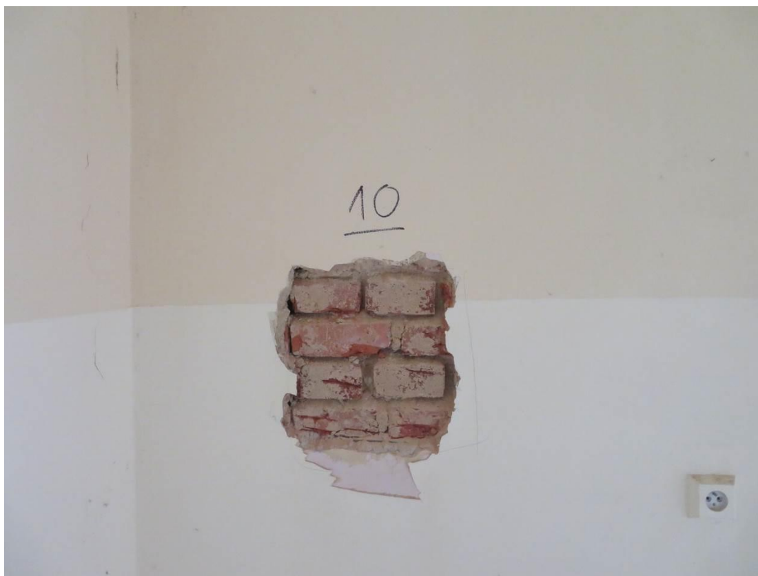
Foto 58 – Zikova 1 – 2.NP – sonda Z10 – viditelné cihly plné pálené a betonové
