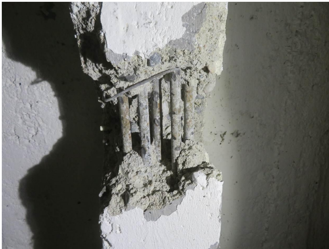
Foto 95 – Šolínova 3 – 1.PP – sonda SS11/T4,D4 – sonda do stropního trámu
