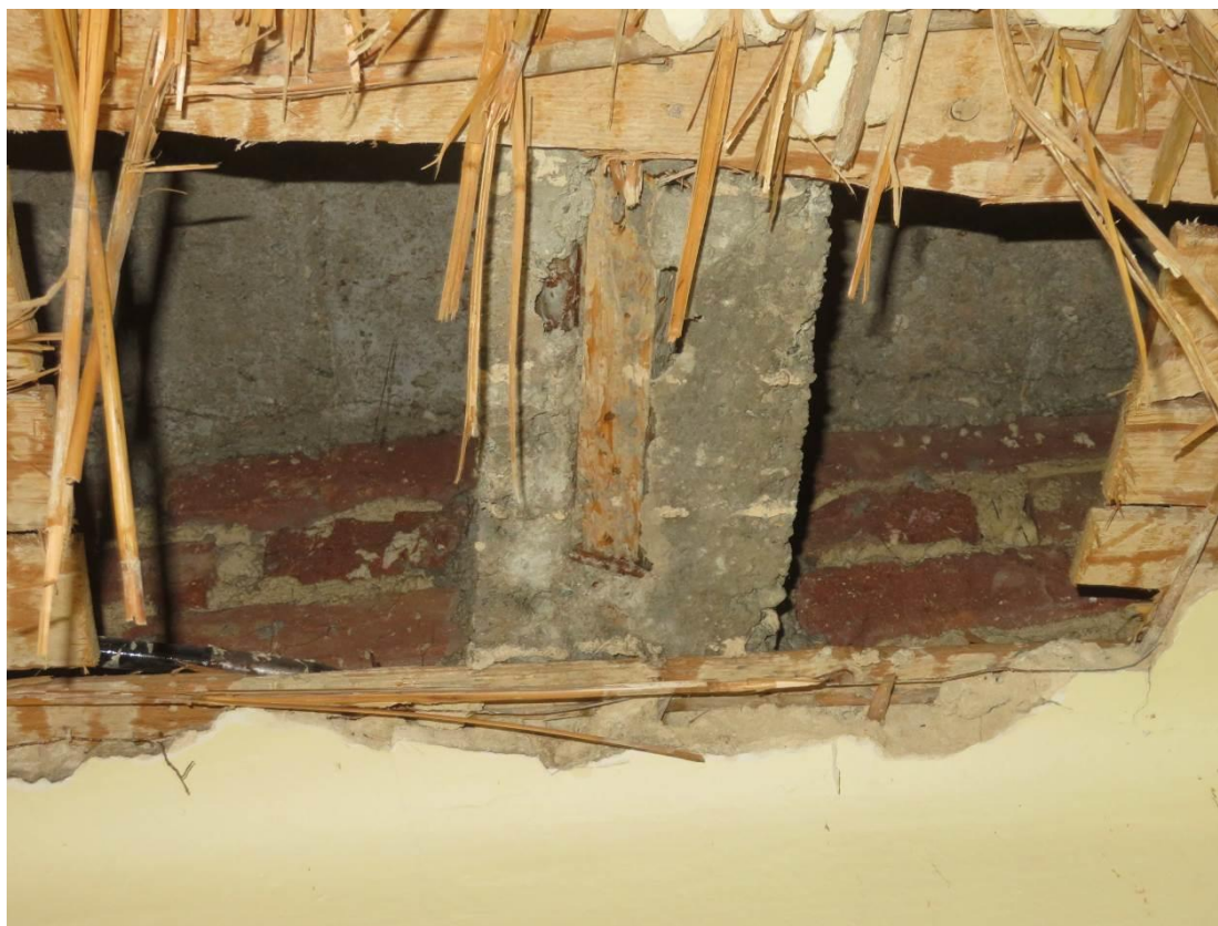
Foto 134 – Zikova 1 – 2.NP – sonda SS26/T12 – pohled na oblast uložení žb trámů přímo do zdiva
