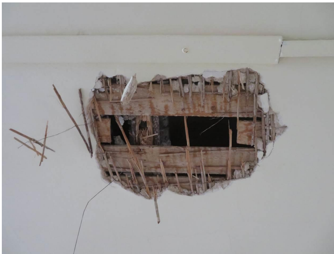
Foto 132 – Zikova 1 – 2.NP – sonda SS26/T12,D12 – sonda do stropního trámu, žb strop s dřevěným podhledem (omítka na rákos)
