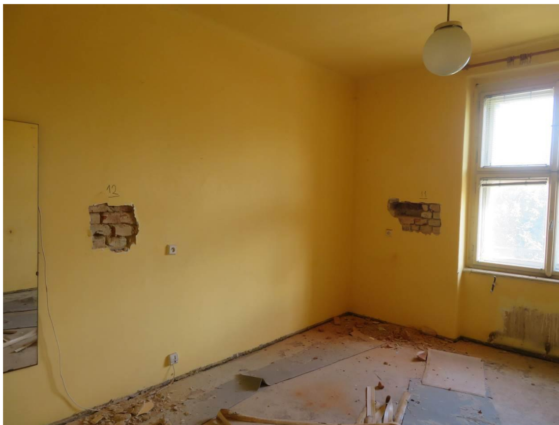
Foto 39 – Šolínova 3 – 2.NP – sonda Z11,12 – viditelné cihly plné pálené a betonové
