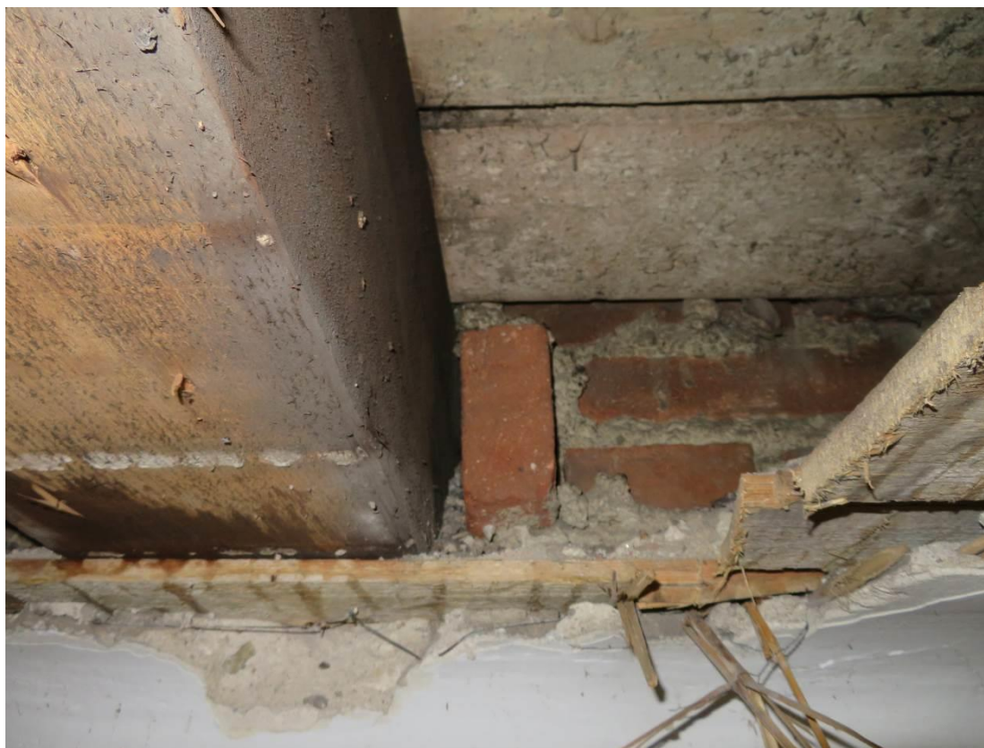
Foto 77 – Šolínova 1 – 1.NP – sonda SS4 – dřevěný trámový strop
