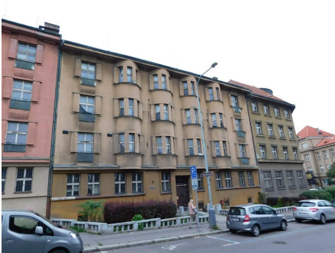
Foto 5 – Celkový pohled na objekt v ul. Šolínova 3 – pohled z ulice Šolínova – viditelné pouze lokální opravy fasády
