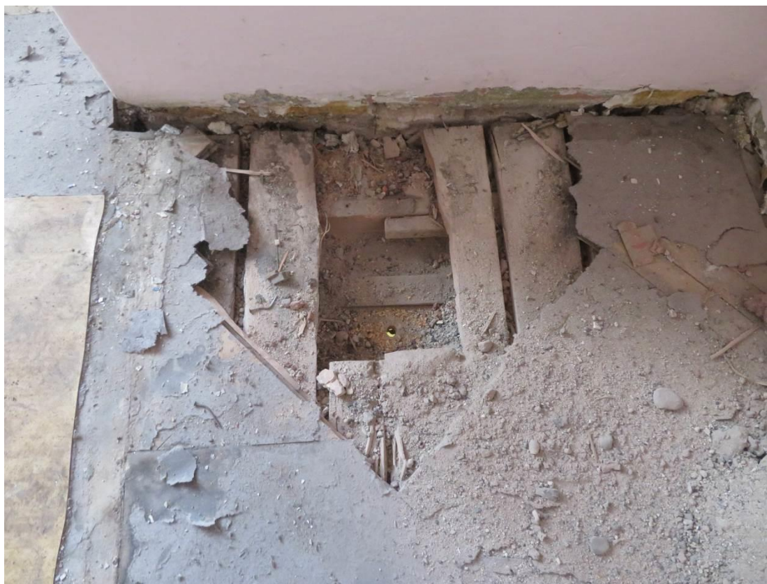
Foto 109 – Šolínova 3 – 4.NP – sonda SS17 – sonda do podlahy
