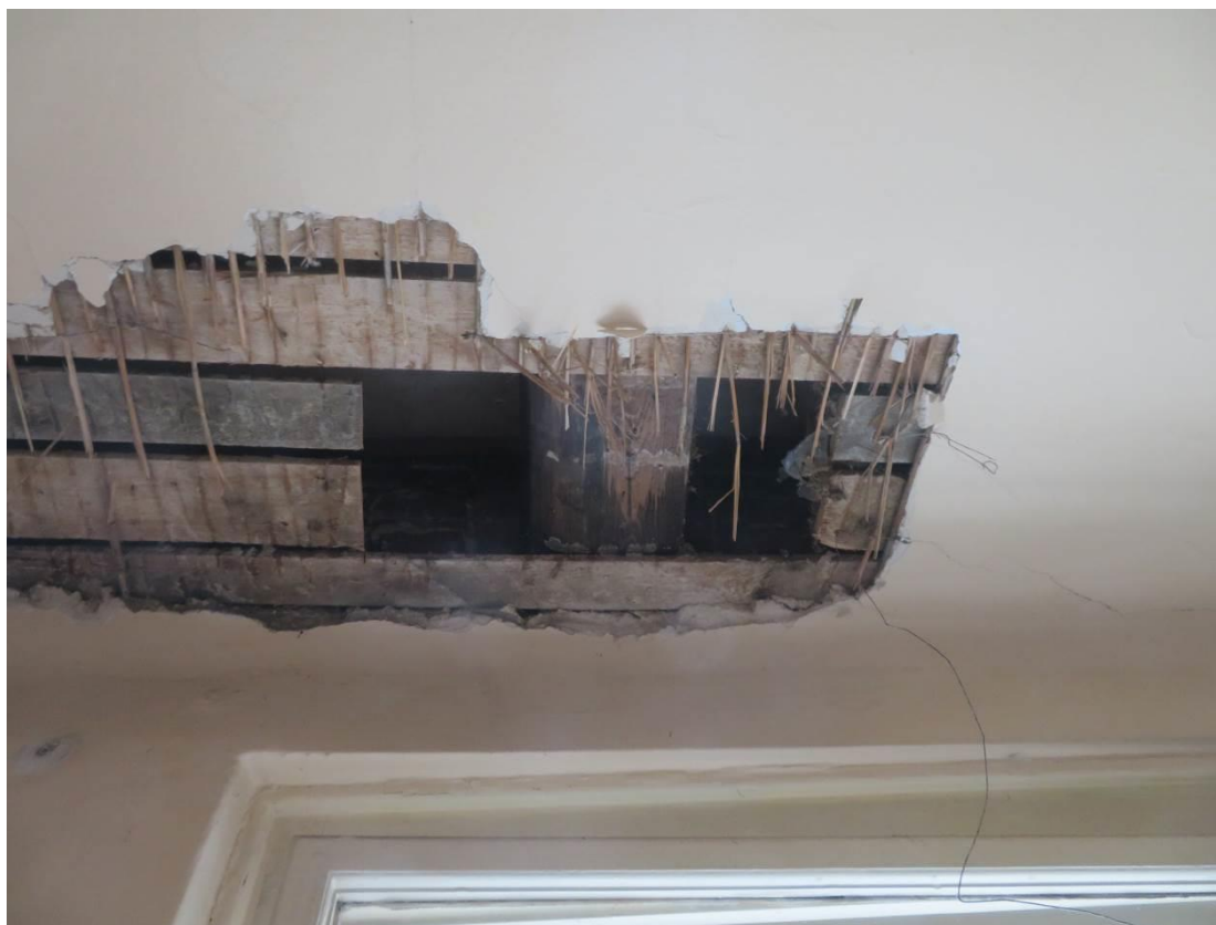
Foto 140 – Zikova 1 – 4.NP – sonda SS29 – dřevěná trémová konstrukce
