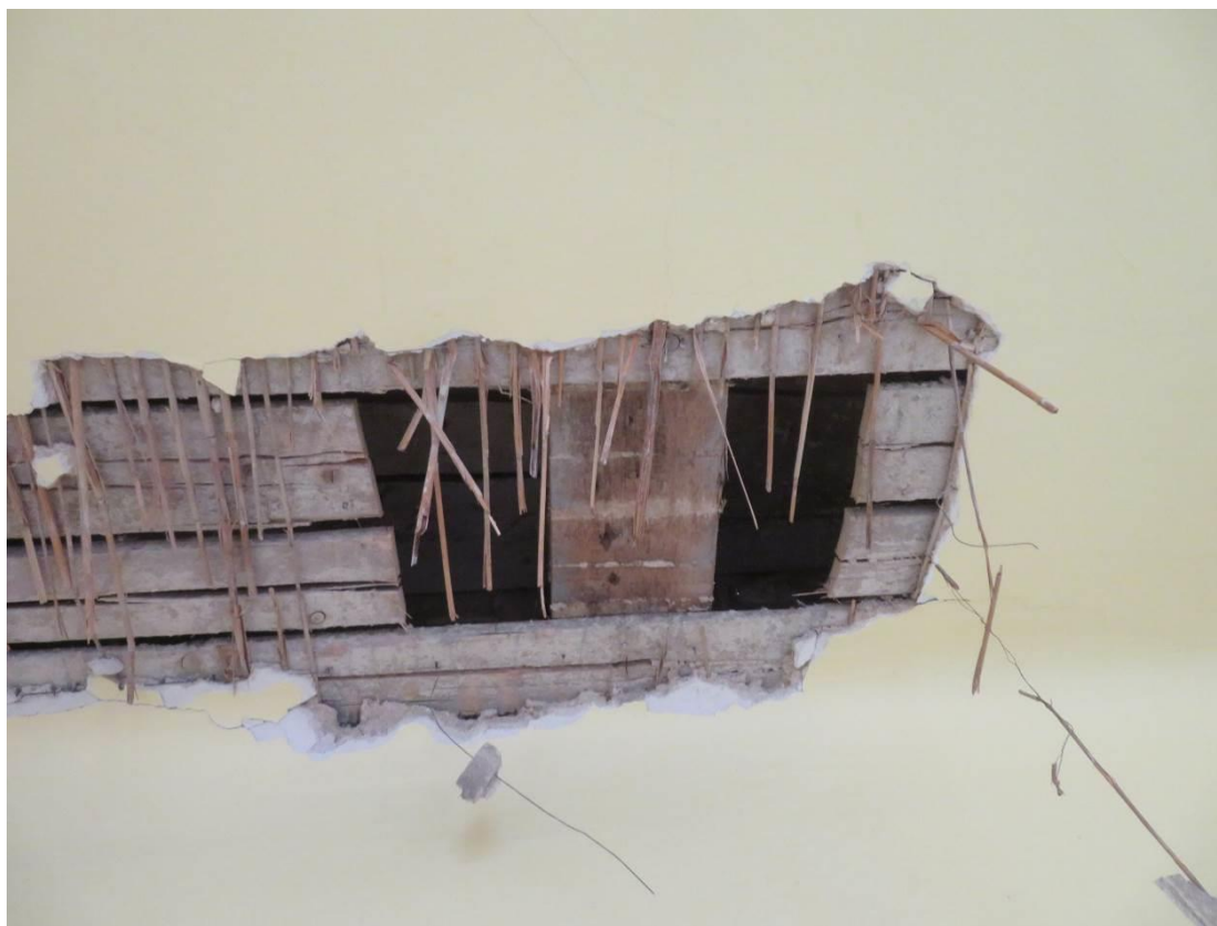
Foto 138 – Zikova 1 – 3.NP – sonda SS28 – dřevěná trémová konstrukce
