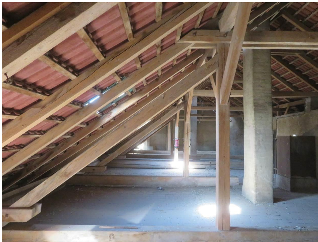
Foto 153 – Šolínova 1 – 6.NP (lokalizace v Příloze 1) – patrný charakter konstrukce krovu, nebyla zjištěna koroze dřeva ani jiné významné poruchy
