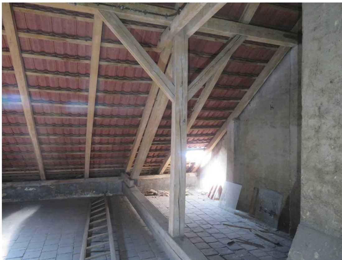
Foto 159 – Šolínova 1 – 6.NP (lokalizace v Příloze 1) – patrný charakter konstrukce krovu, nebyla zjištěna koroze dřeva ani jiné významné poruchy
