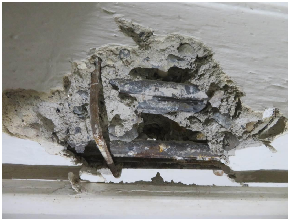
Foto 97 – Šolínova 3 – 1.PP – sonda SS12/T5 – sonda do stropního trámu
