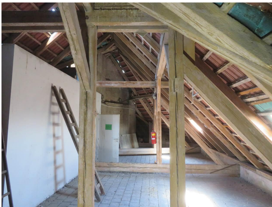
Foto 166 – Žikova 1 – 5.NP (lokalizace v Příloze 1) – patrný charakter konstrukce krovu, nebyla zjištěna koroze dřeva ani jiné významné poruchy
