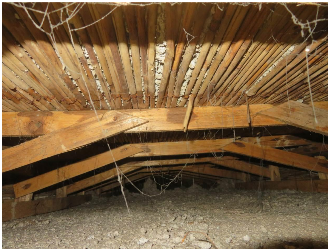
Foto 124 – Zikova 1 – 1.NP – sonda SS23/T10,D10 – pohled do dutiny, charakter provedení bednění z rákosu
