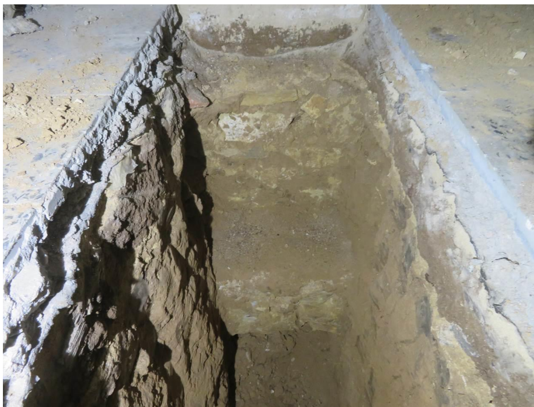
Foto 94 – Šolínova 3 – 1.PP – sonda KS2 – charakter základové konstrukce
