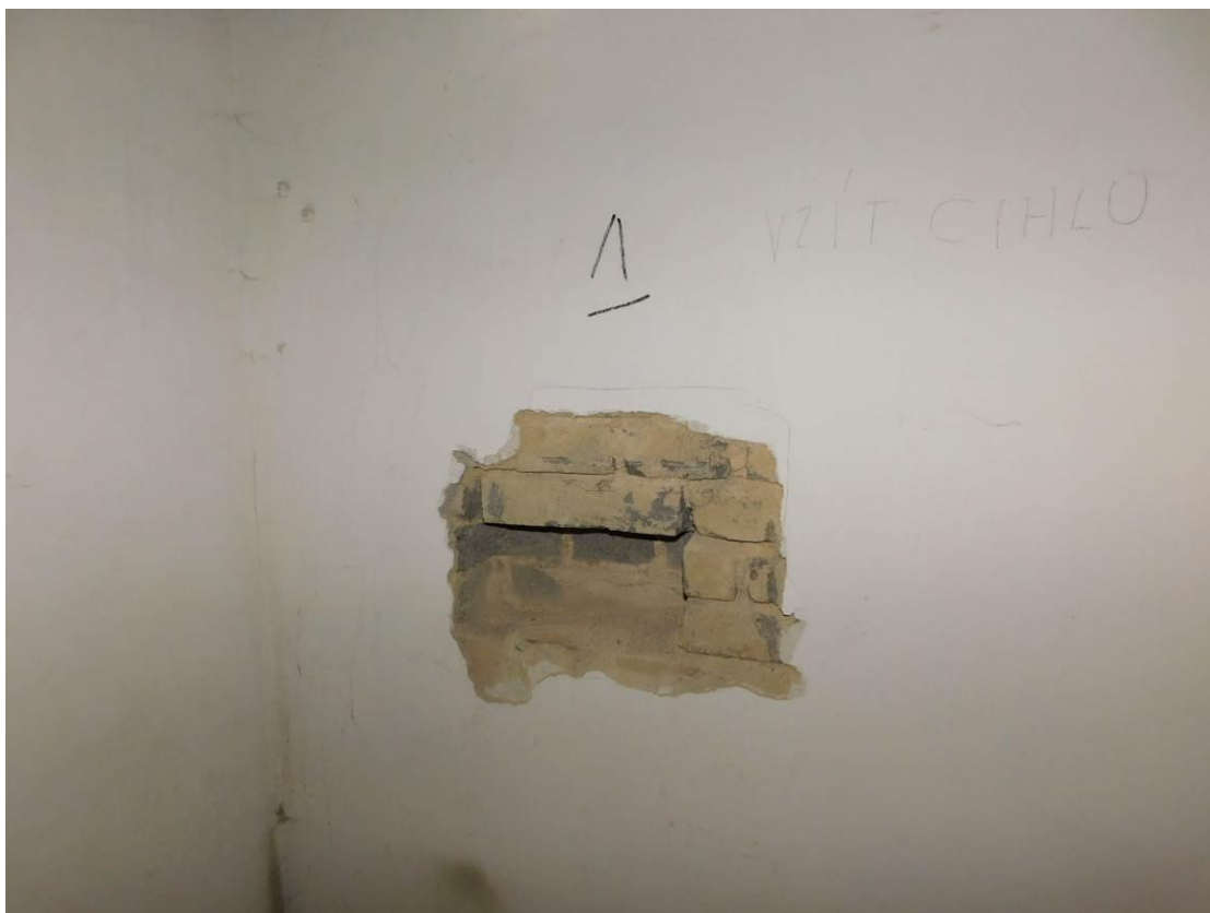
Foto 17 – Objekt Šolínova 1 – 1.PP – sonda Z1 – viditelné betonové cihly
