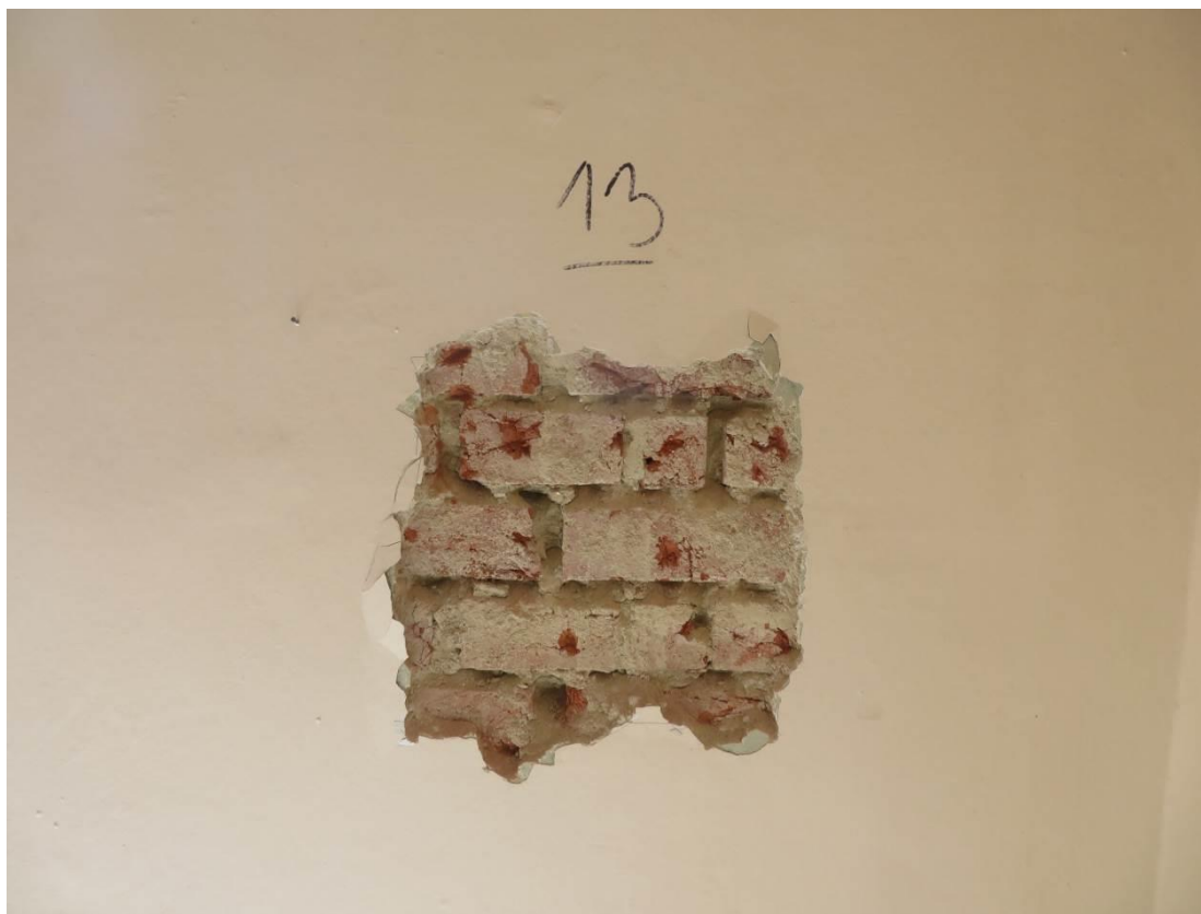
Foto 25 – Objekt Šolínova 1 – 4.NP – sonda Z13 – viditelné cihly plné pálené
