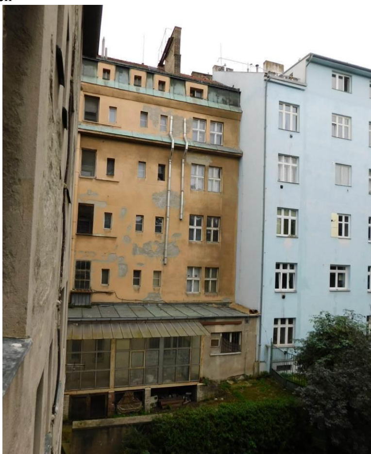
Foto 12 – Celkový pohled na objekt Šolínova 1 – pohled dvorní – viditelné pouze lokální opravy fasády
