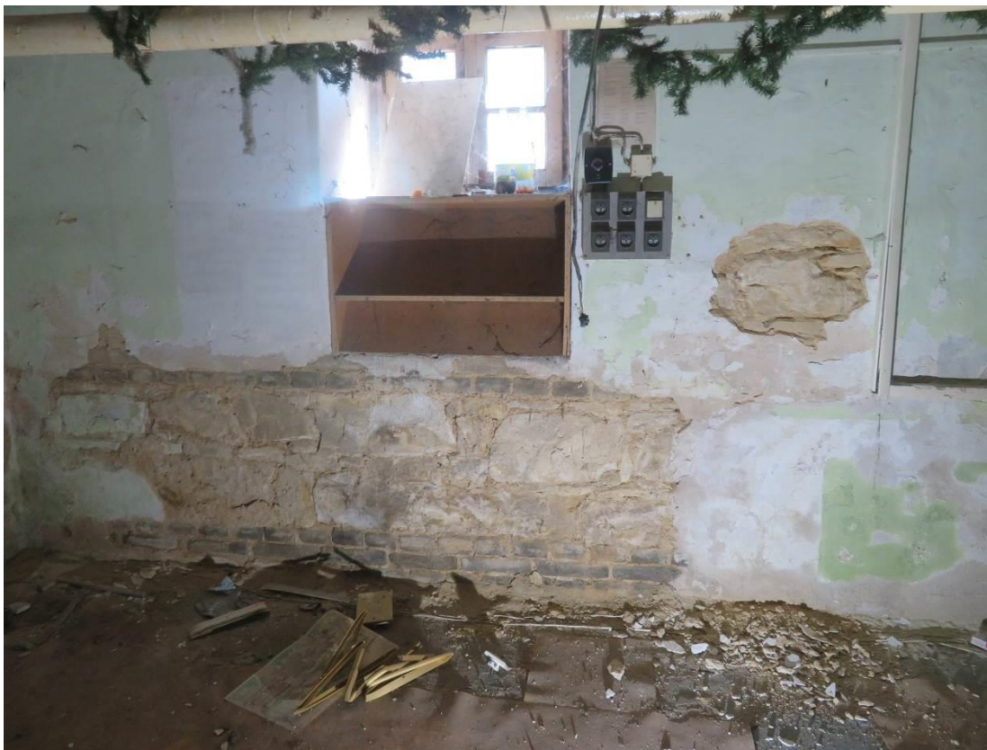
Foto 19 – Objekt Šolínova 1 – 1.PP – sonda Z2 – viditelné smíšené zdivo
