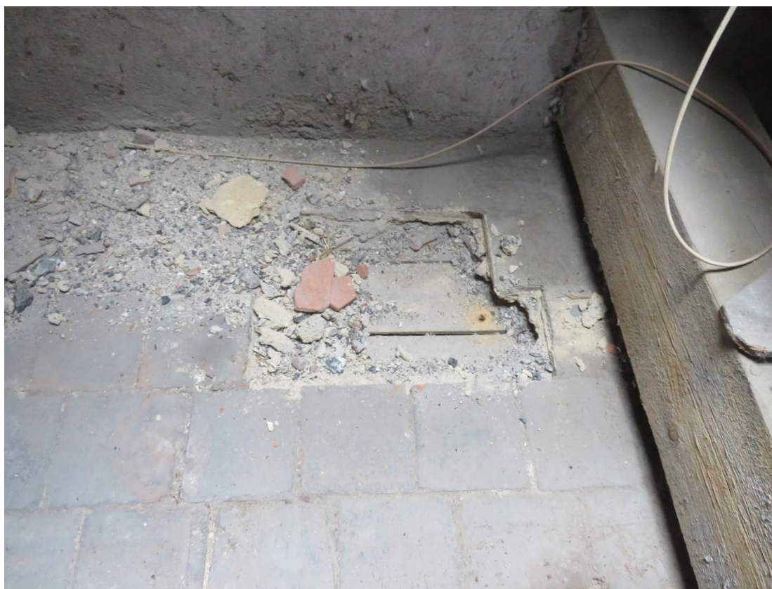
Foto 114 – Šolínova 3 – 5.NP – sonda SS19 – sonda do podlahy
