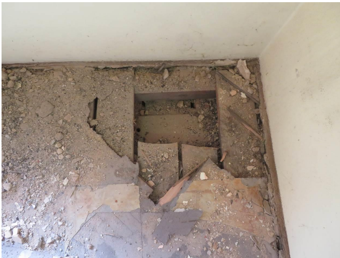
Foto 80 – Šolínova 1 – 2.NP – sonda SS3 – sonda do podlahy
