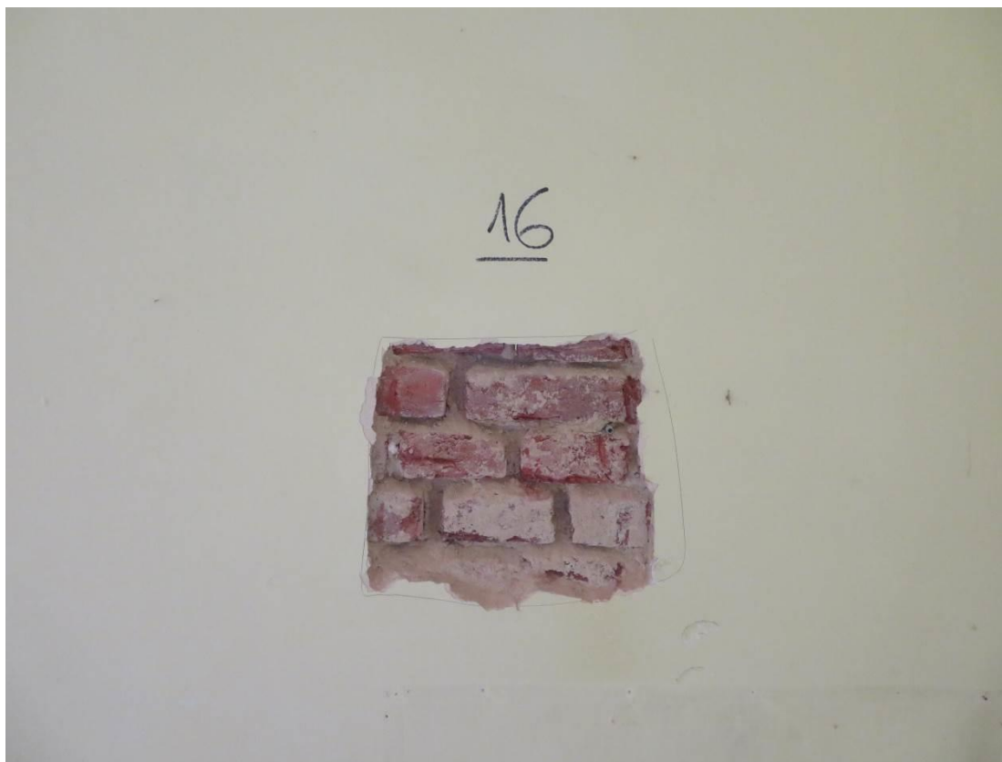
Foto 63 – Zikova 1 – 3.NP – sonda Z16 – viditelné cihly plně pálené
