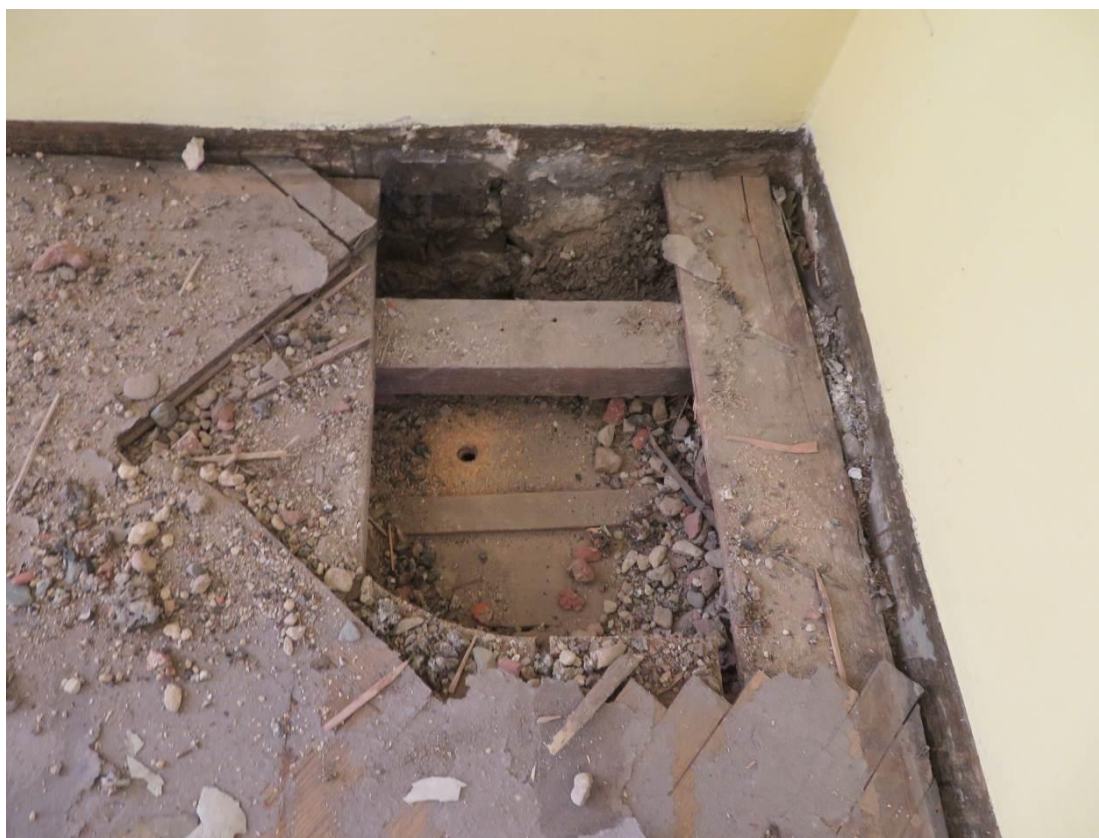
Foto 78 – Šolínova 1 – 2.NP – sonda SS4 – sonda do podlahy
