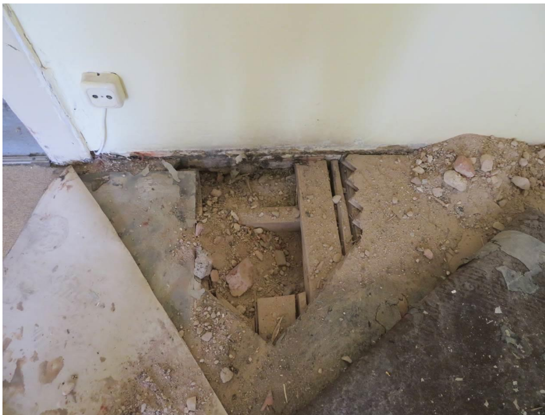
Foto 112 – Šolínova 3 – 4.NP – sonda SS18 – sonda do podlahy
