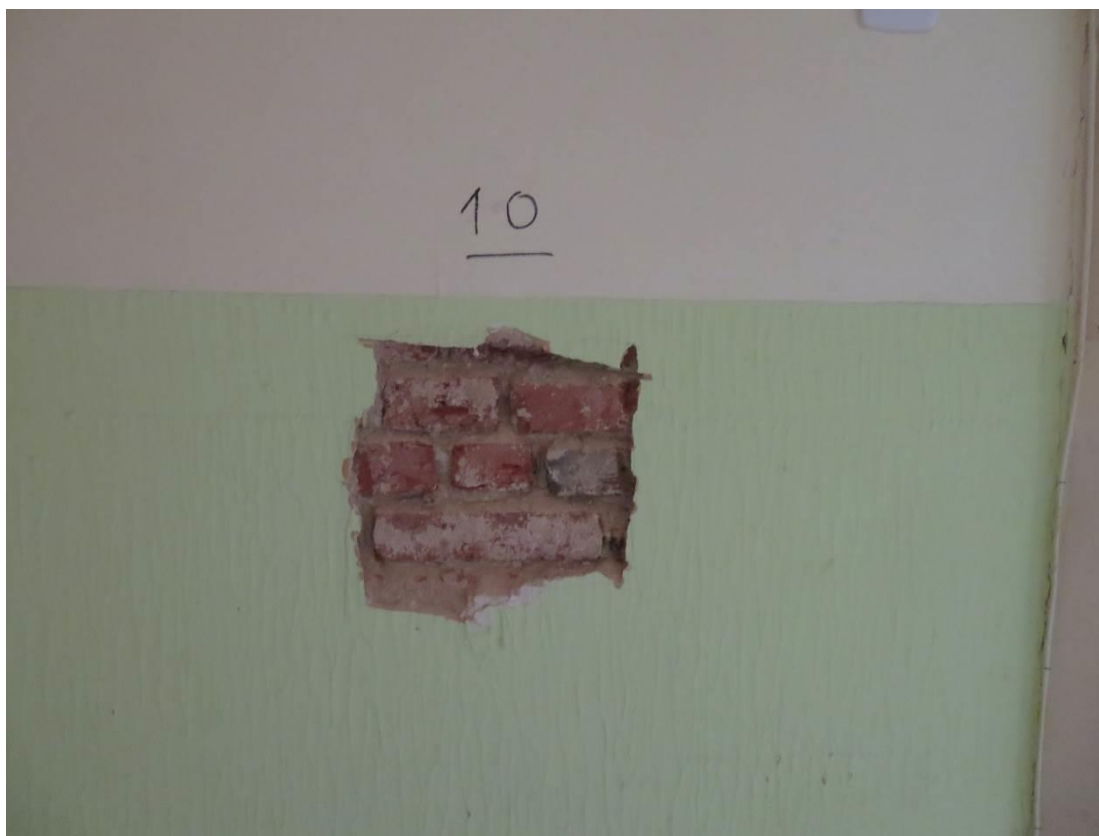
Foto 38 – Šolínova 3 – 2.NP – sonda Z10 – viditelné cihly plné pálené a betonové
