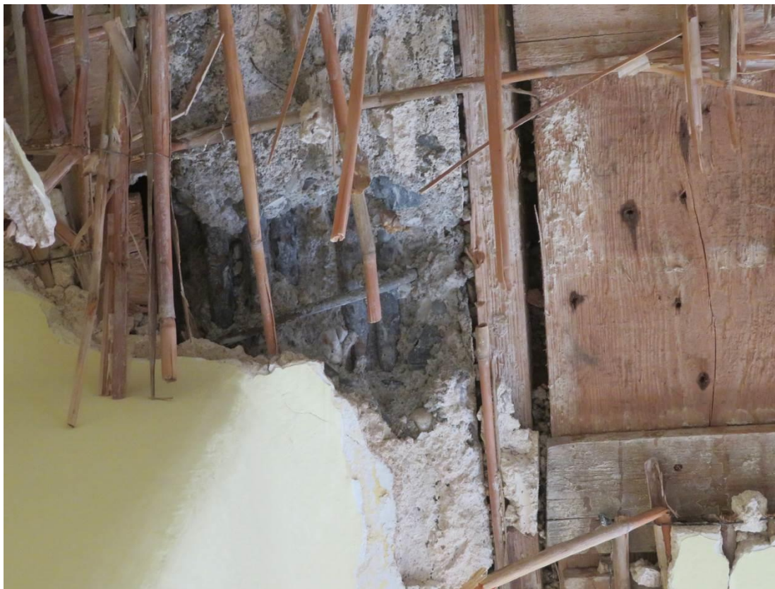
Foto 111 – Šolínova 3 – 3.NP – sonda SS18/T7 – detail sondy k výztuži trámu T7
