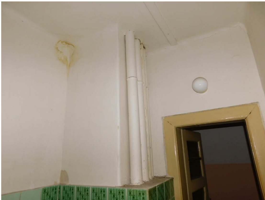
Foto 152 – Šolínova 3 – 4.NP (lokalizace v Příloze 1) – viditelná stoupačka teplé vody
