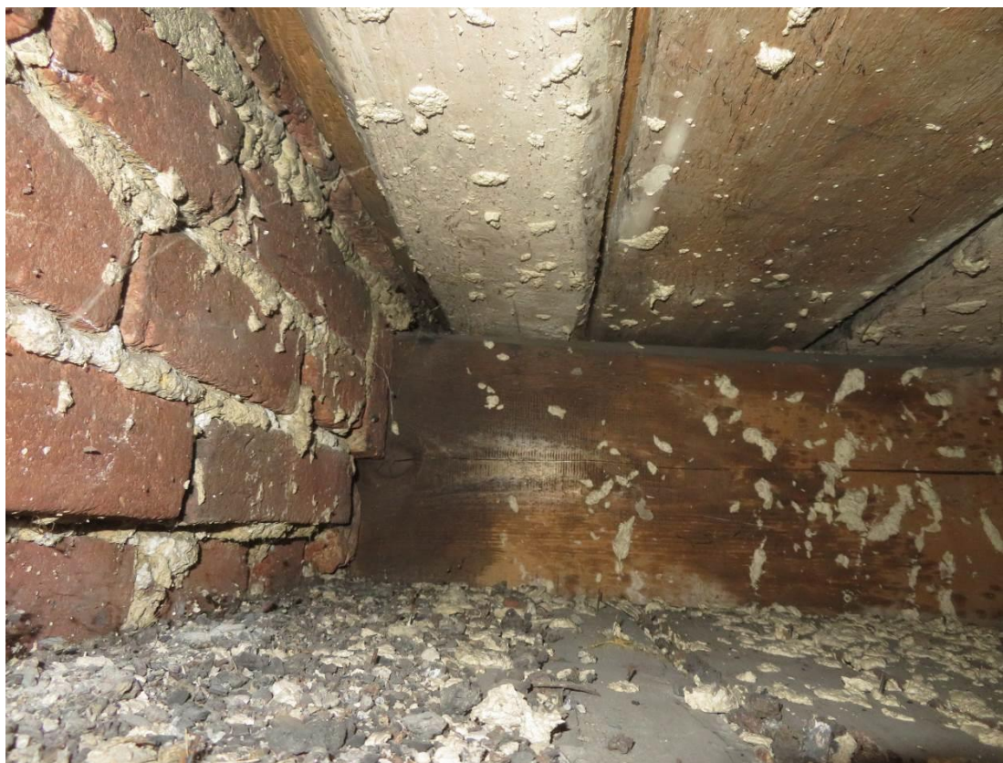
Foto 142 – Zikova 1 – 4.NP – sonda SS29 – pohled do dutiny na uložení trámu do stěny
