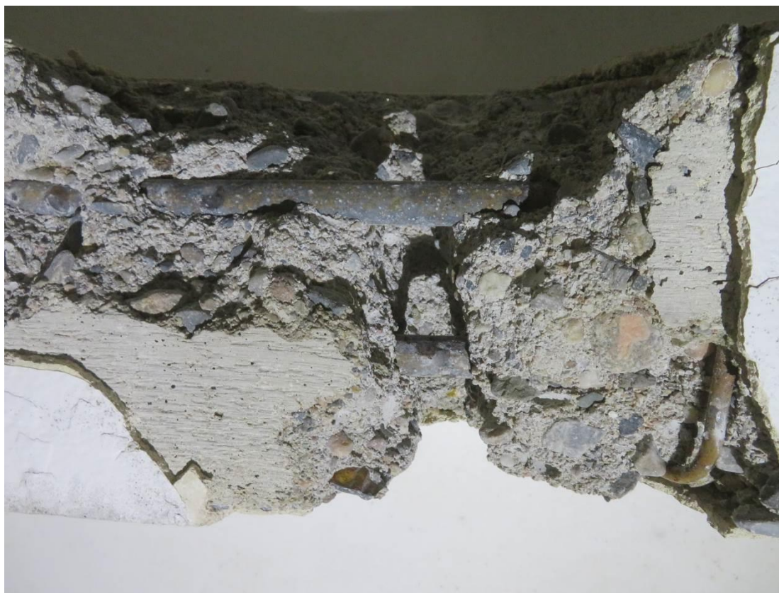
Foto 120 – Zikova 1 – 1.PP – sonda SS22/T9,D9 – sonda do stropního trámu a desky
