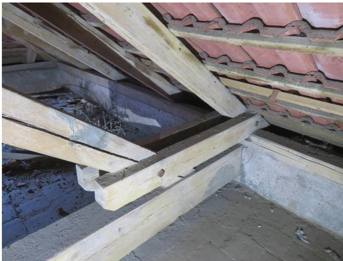
Foto 155 – Šolínova 1 – 6.NP (lokalizace v Příloze 1) – patrný charakter konstrukce krovu, nebyla zjištěna koroze dřeva ani jiné významné poruchy
