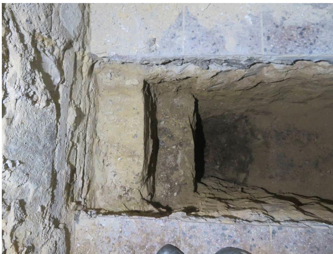
Foto 70 – Šolínova 1 – 1.PP – sonda KS1 – charakter základové konstrukce
