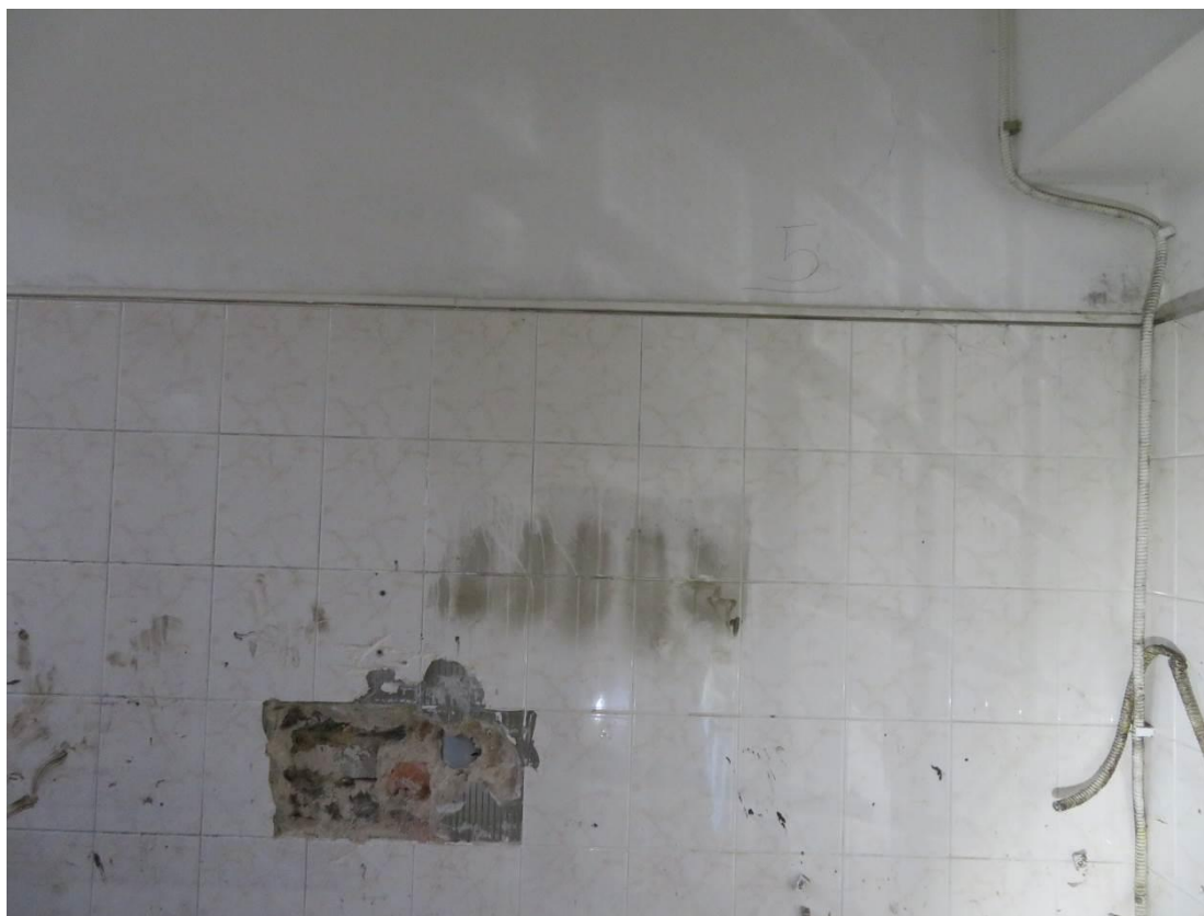
Foto 53 – Zikova 1 – 1.PP – sonda Z5 – viditelné betonové cihly
