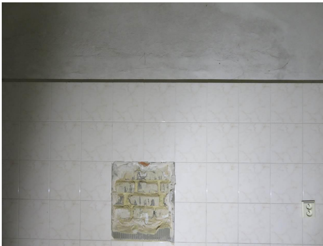
Foto 47 – Zikova 1 – 1.PP – sonda Z1 – viditelné betonové cihly
