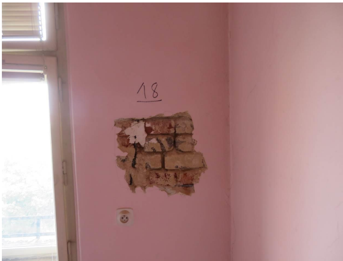
Foto 67 – Zikova 1 – 4.NP – sonda Z18 – viditelné cihly plně pálené a betonové
