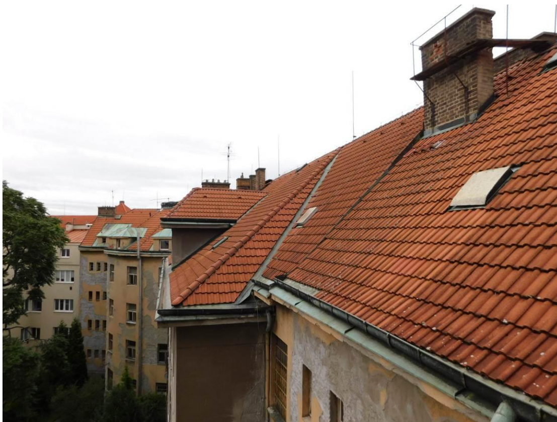
Foto 14 – Celkový pohled na střešní krytinu objektu Šolínova 3 – pohled dvorní – bez viditelných poruch
