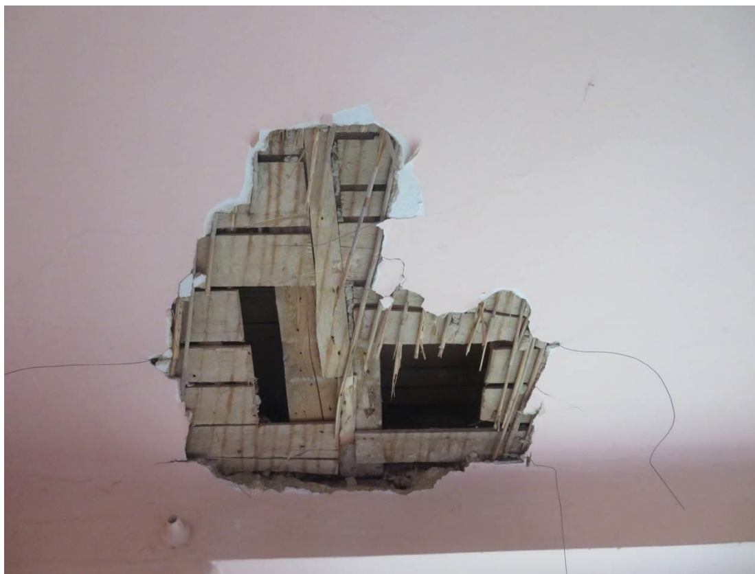
Foto 103 – Šolínova 3 – 2.NP – sonda SS15 – dřevěný trámový strop
