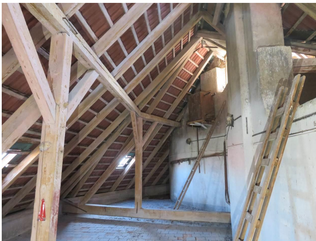
Foto 168 – Zikova 1 – 5.NP (lokalizace v Příloze 1) – patrný charakter konstrukce krovu, nebyla zjištěna korozí dřeva ani jiné významné poruchy
