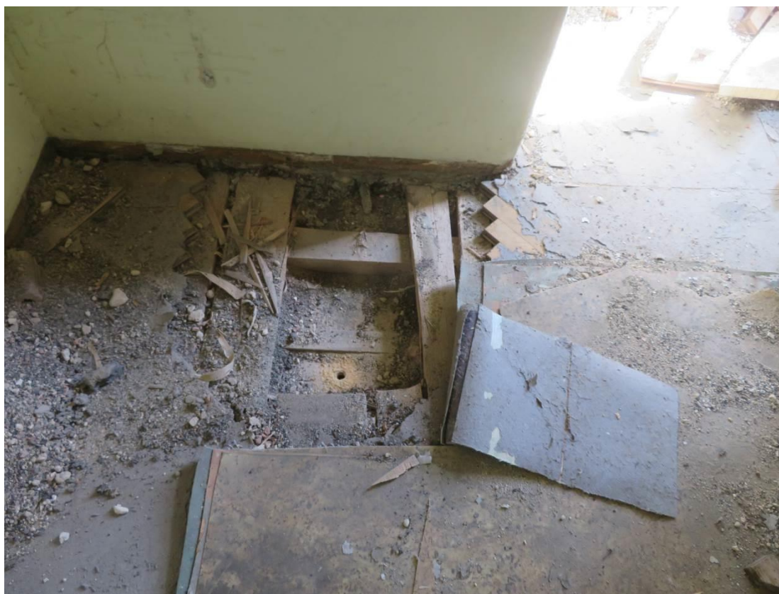
Foto 102 – Šolínova 3 – 2.NP – sonda SS14 – sonda do podlahy
