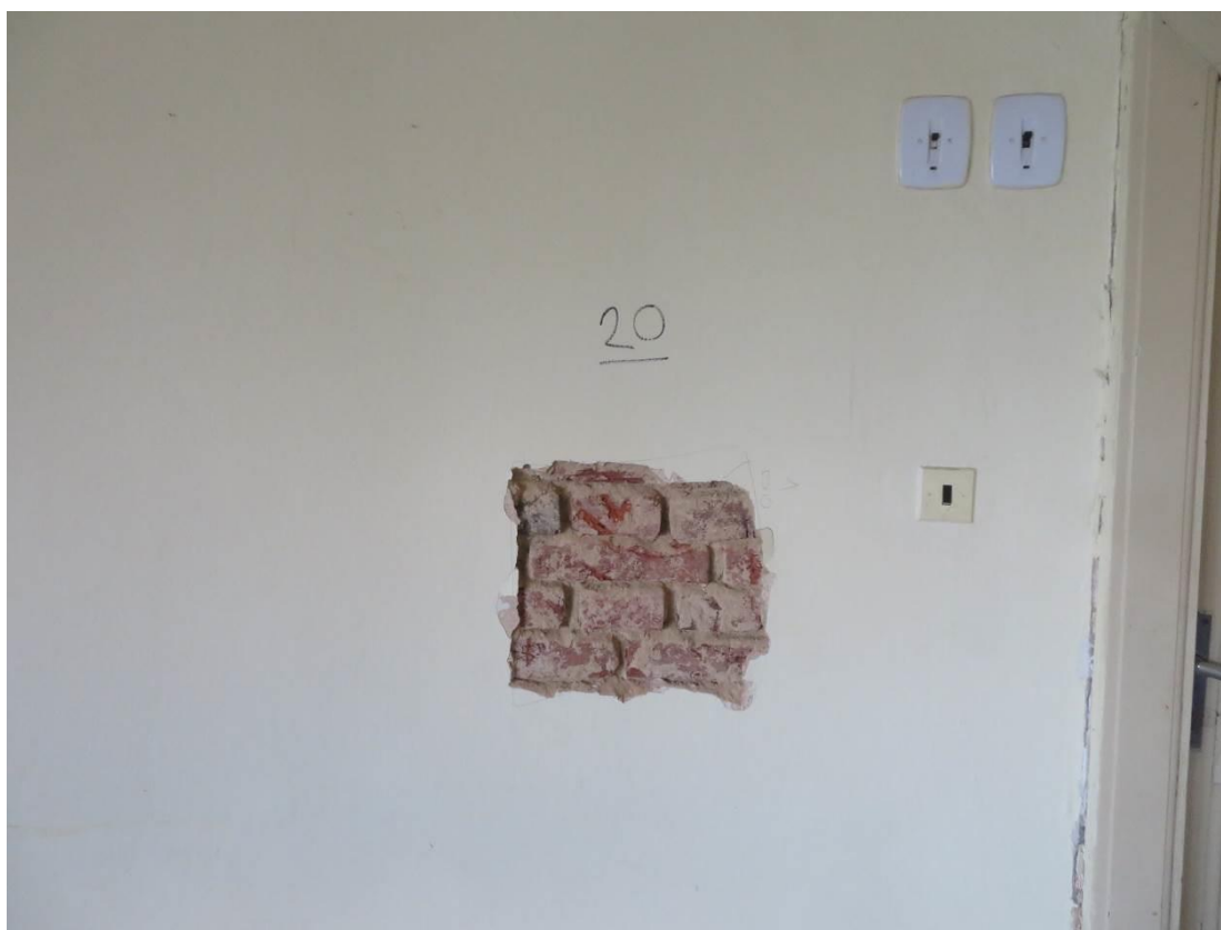
Foto 68 – Zikova 1 – 4.NP – sonda Z20 – viditelné cihly plně pálené a betonové
