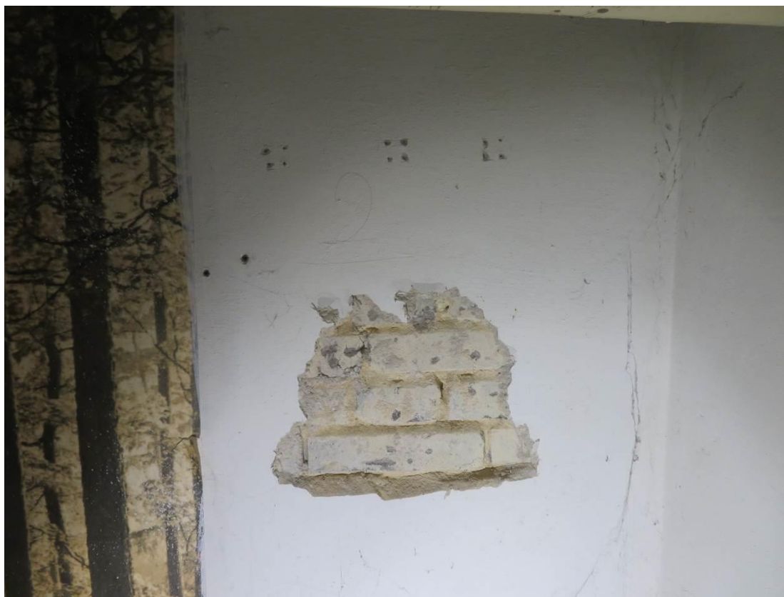
Foto 33 – Objekt Šolínova 3 – 1.PP – sonda Z2 – zdivo z betonových cihel,
