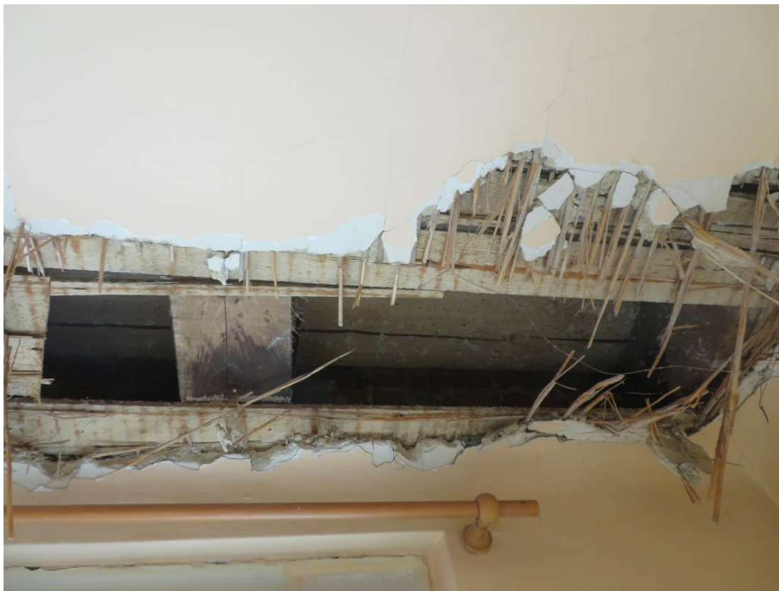
Foto 89 – Šolínova 1 – 5.NP – sonda SS9 – dřevěný trámový strop
