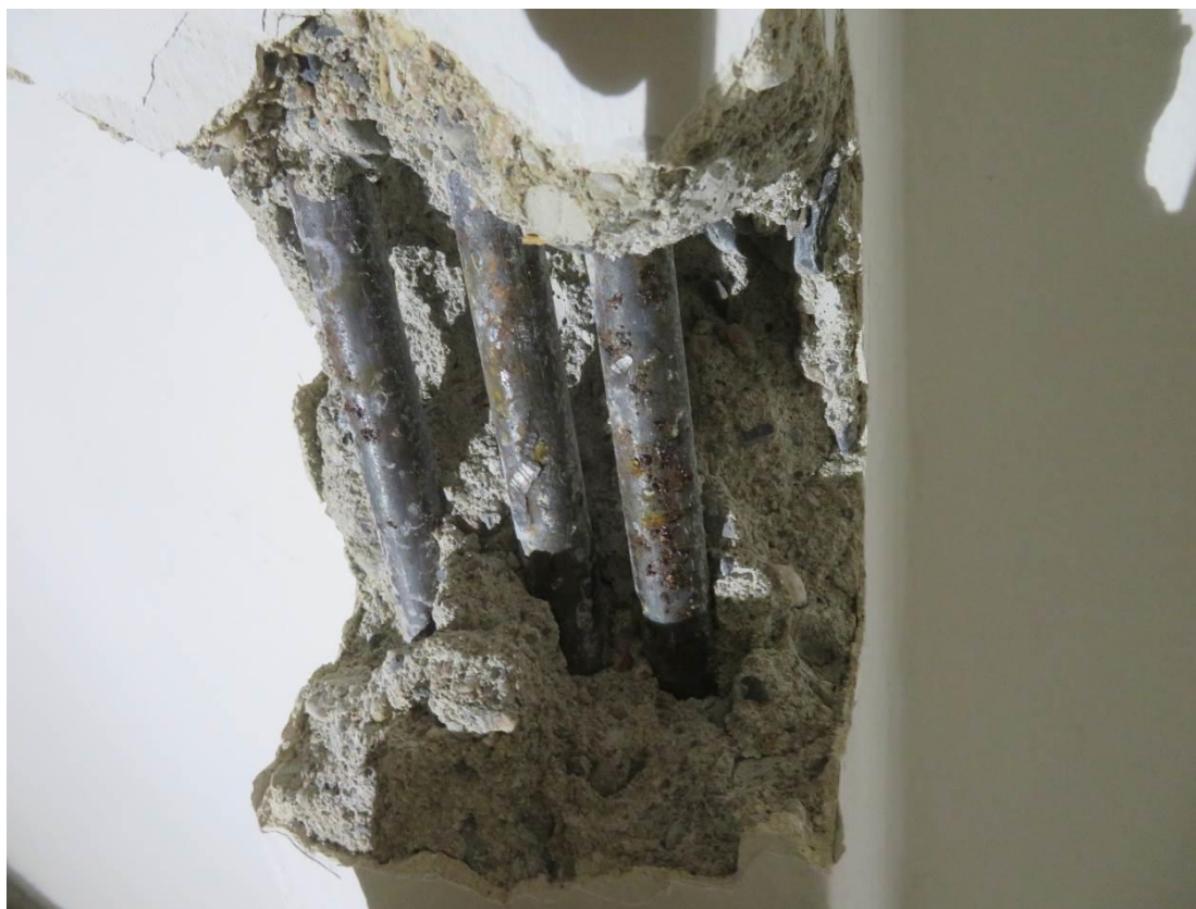
Foto 118 – Zikova 1 – 1.PP – sonda SS21/T8,D8 – sonda do stropního trámu a desky
