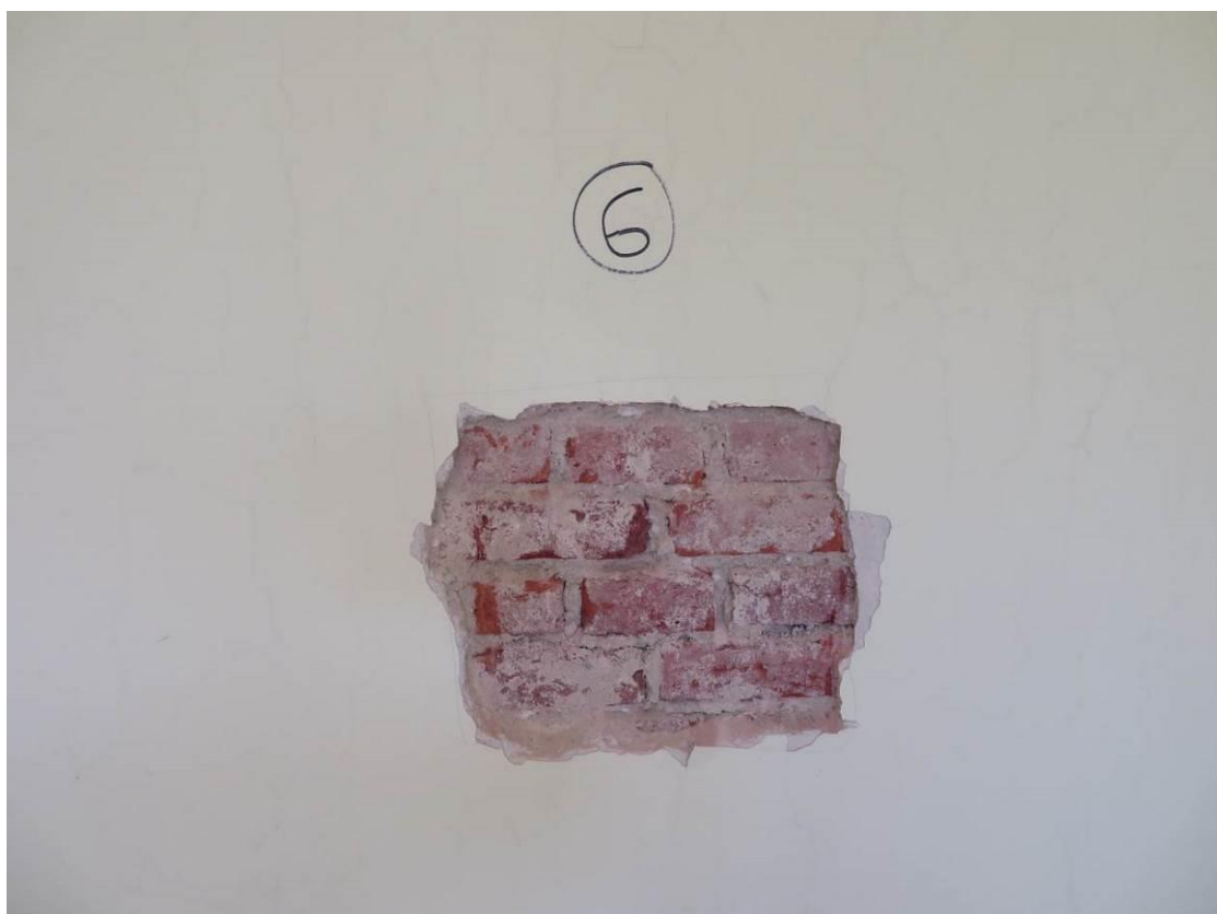
Foto 22 – Objekt Šolínova 1 – 1.NP – sonda Z6 – viditelné cihly plně pálené
