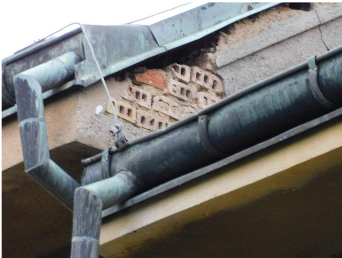
Foto 7 – Celkový pohled na objekt v ul. Šolínova 1 – detail provedení štítové stěny
