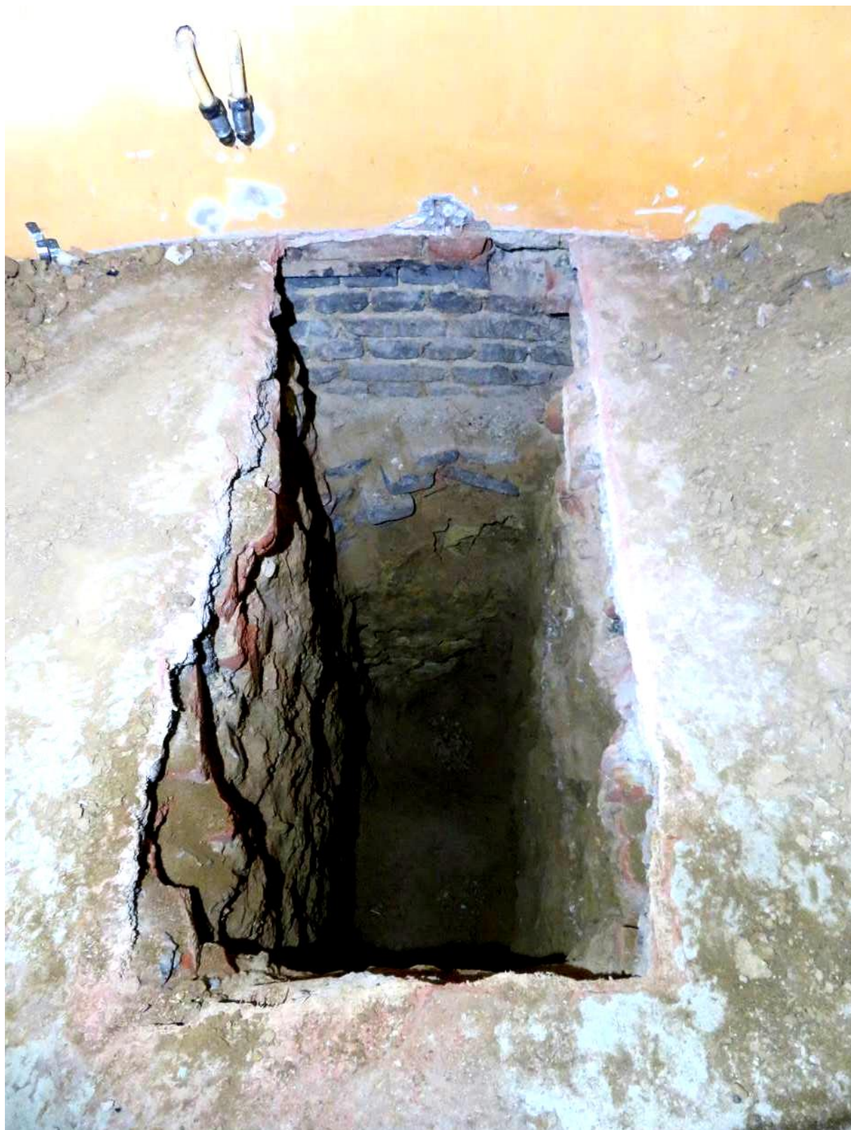
Foto 117 – Zikova 1 – 1.PP – sonda KS3 – charakter základové konstrukce
