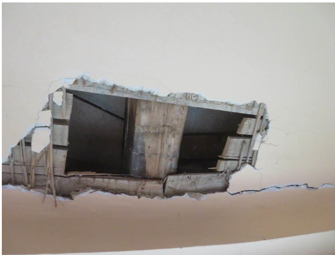
Foto 128 – Zikova 1 – 2.NP – sonda SS25 – dřevěná trámová konstrukce
