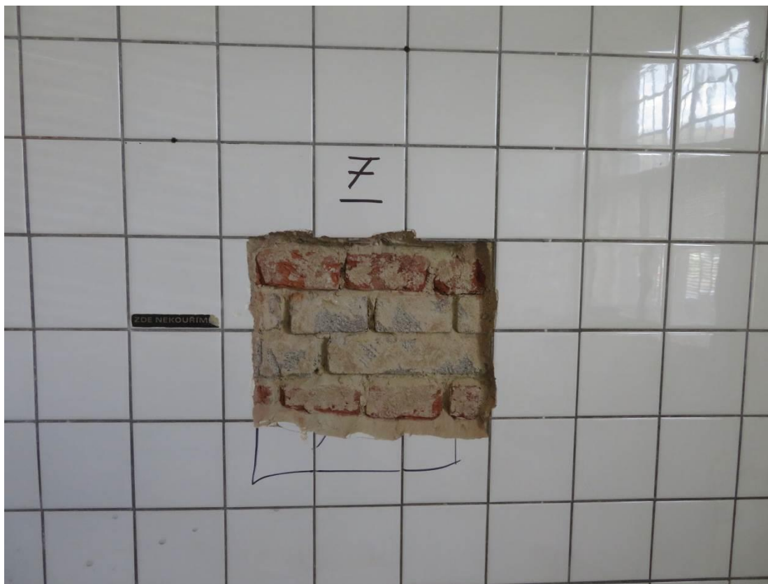
Foto 55 – Zikova 1 – 1.NP – sonda Z7 – viditelné cihly plné pálené a betonové
