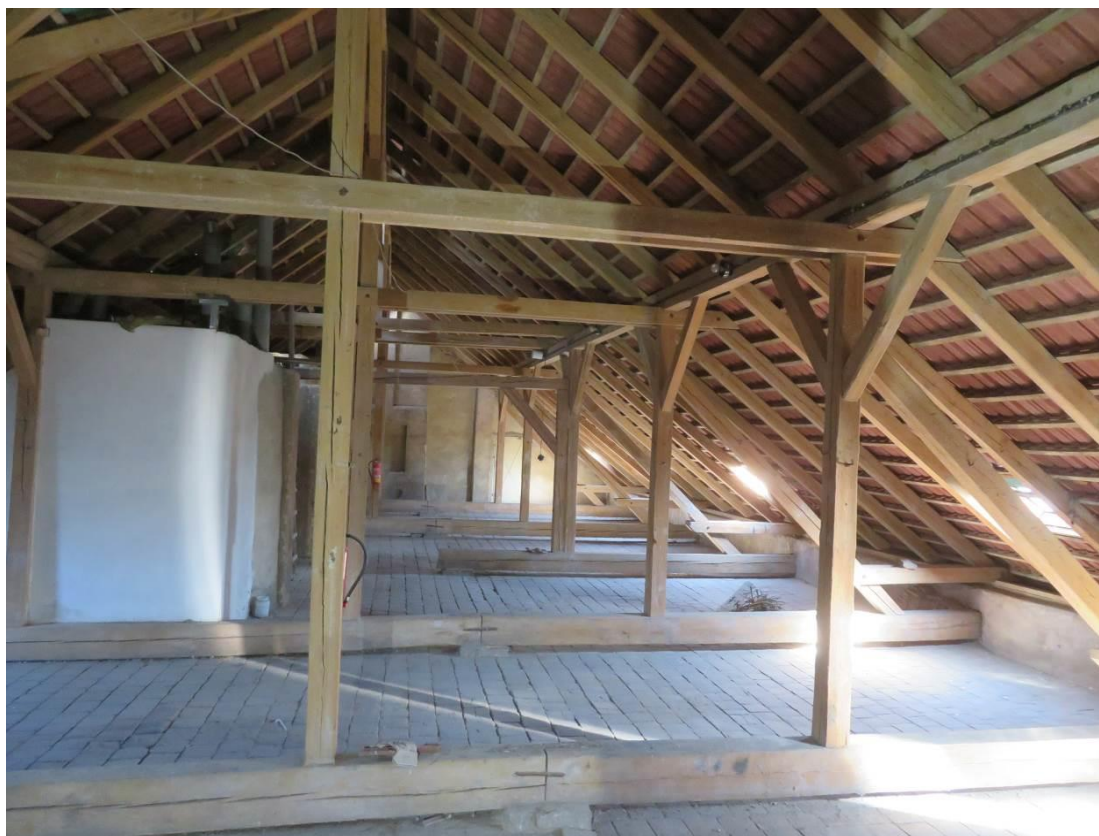
Foto 161 – Šolínova 3 – 5.NP (lokalizace v Příloze 1) – patrný charakter konstrukce krovu, nebyla zjištěna koroze dřeva ani jiné významné poruchy
