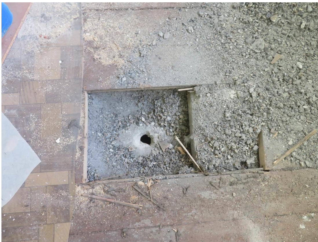
Foto 76 – Šolínova 1 – 1.NP – sonda SS2/D2 – sonda do podlahy 1.NP
