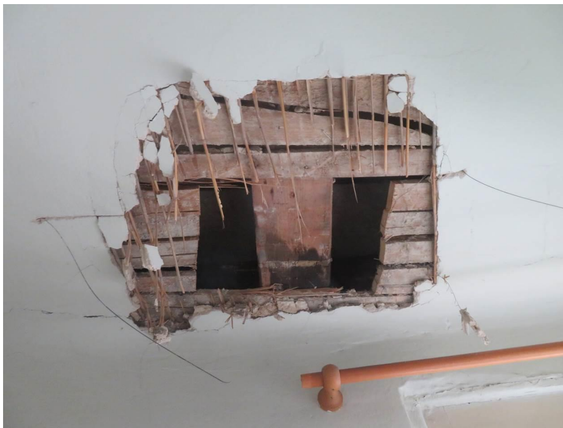
Foto 144 – Zikova 1 – 4.NP – sonda SS30 – dřevěná trámová konstrukce
