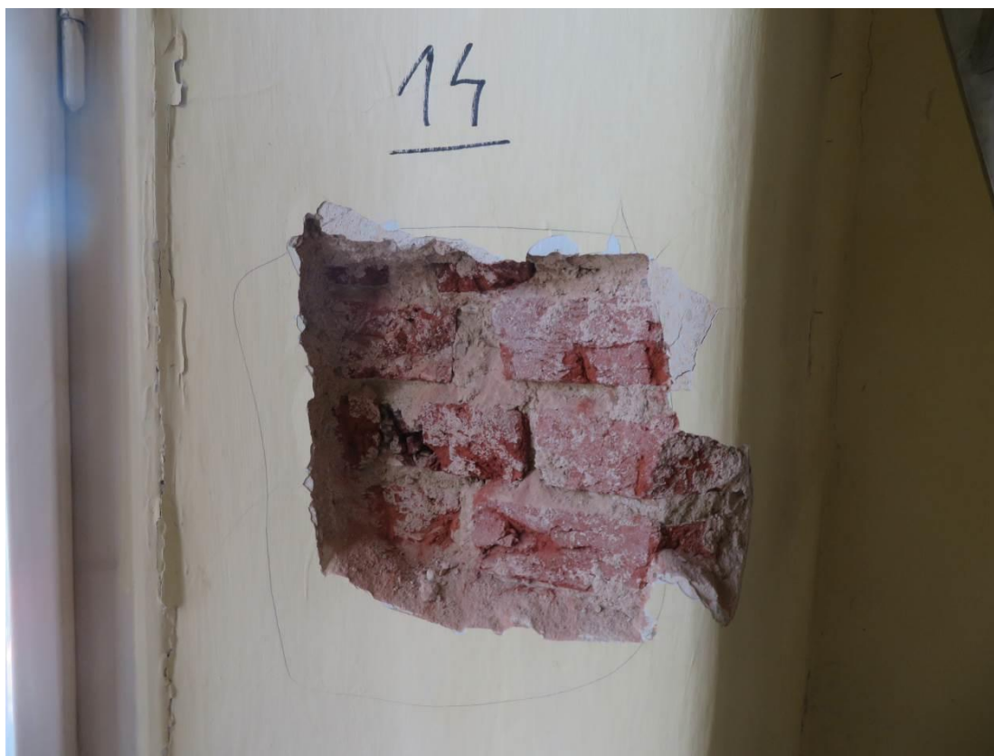
Foto 40 – Šolínova 3 – 3.NP – sonda Z14 – viditelné cihly plné pálené
