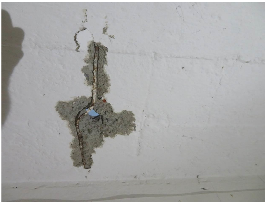
Foto 98 – Šolínova 3 – 1.PP – sonda SS12/D5 – sonda do stropního trámu
