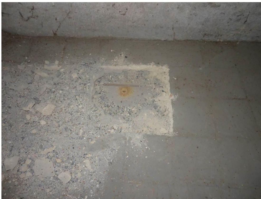
Foto 116 – Šolínova 3 – 5.NP – sonda SS20 – sonda do podlahy
