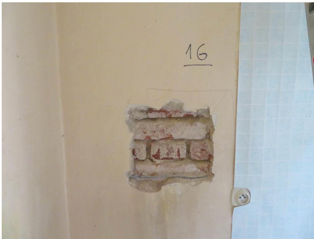
Foto 42 – Šolínova 3 – 5.NP – sonda Z16 – viditelné cihly plně pálené
