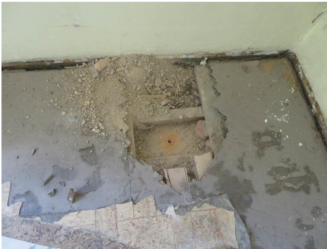
Foto 107 – Šolínova 3 – 3.NP – sonda SS16 – sonda do podlahy
