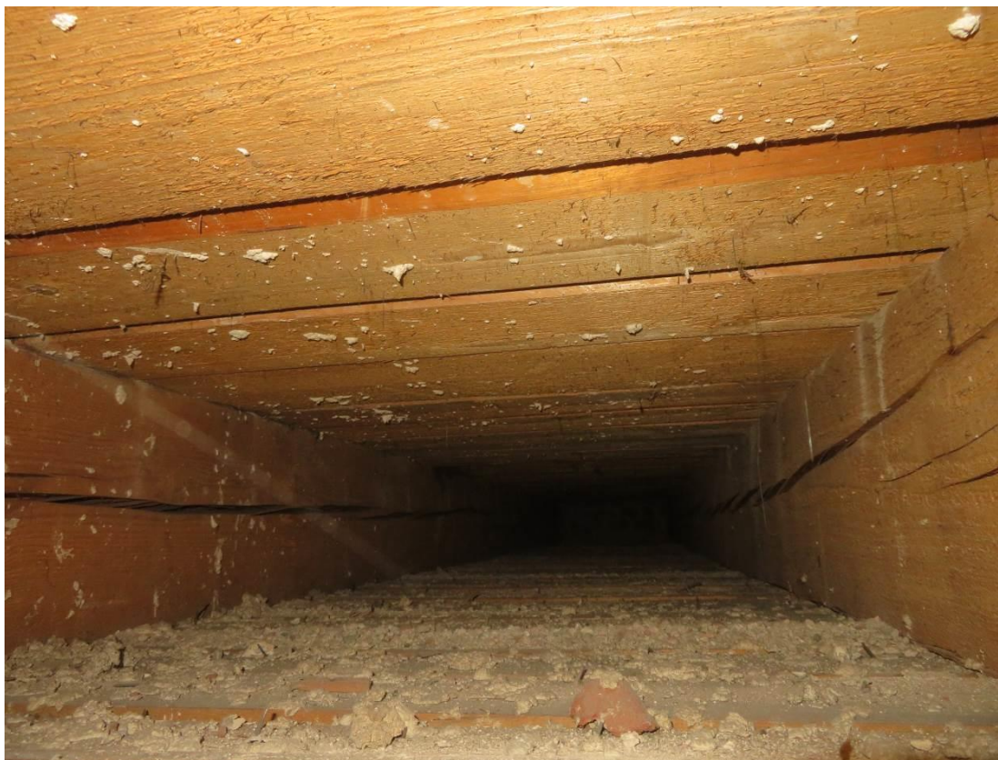
Foto 106 – Šolínova 3 – 3.NP – sonda SS16 – pohled do dutiny
