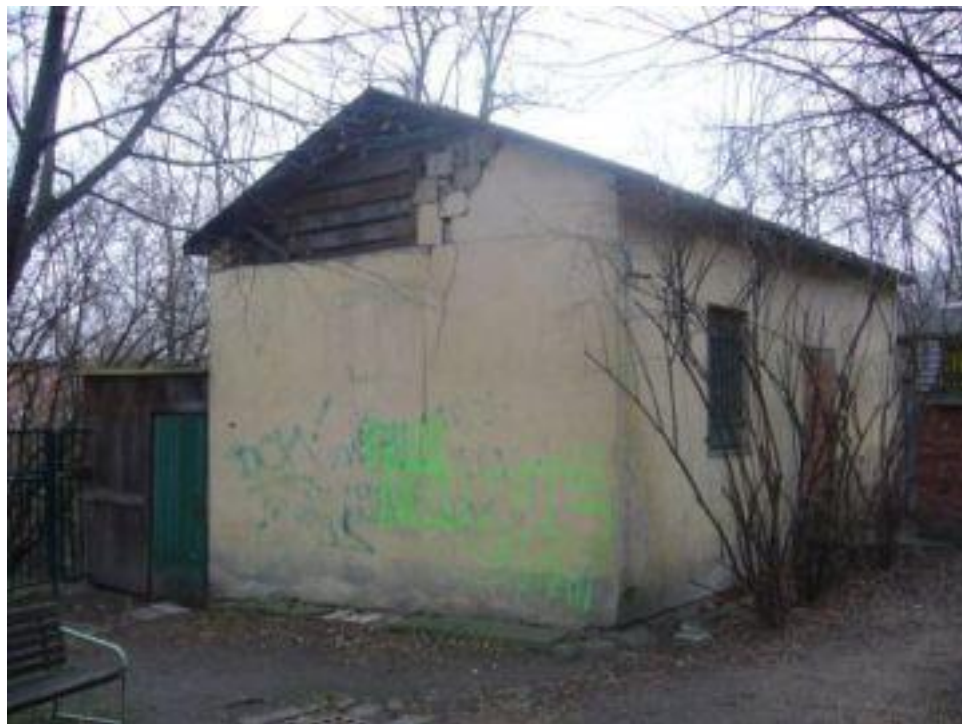
Zděný objekt pohled z hřiště
