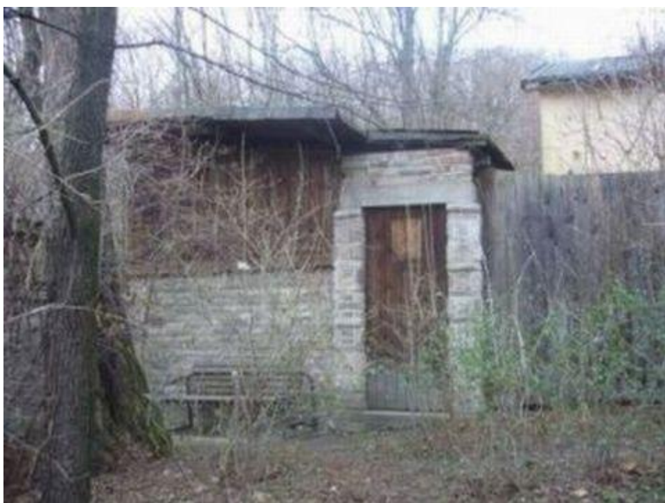
Pohled od jihu
