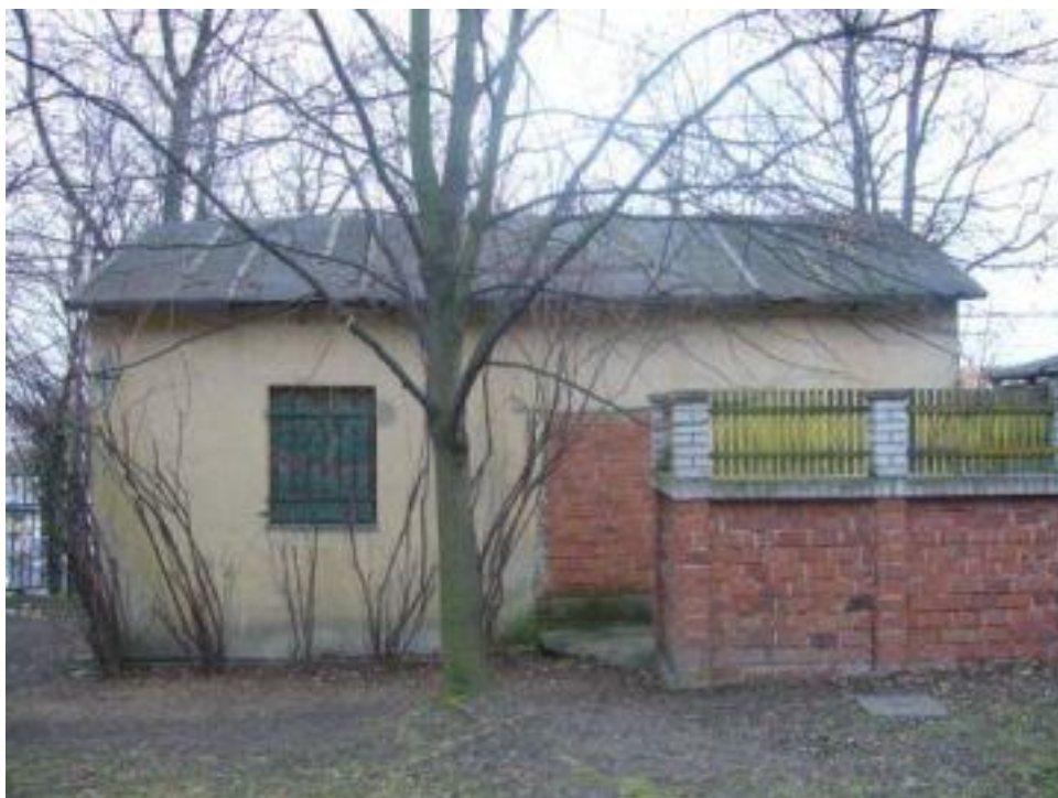
Zděný objekt pohled od severu
