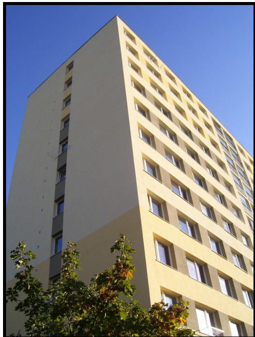
Typická zástavba – 11 podlažní objekt (Mendlova 538-539)
