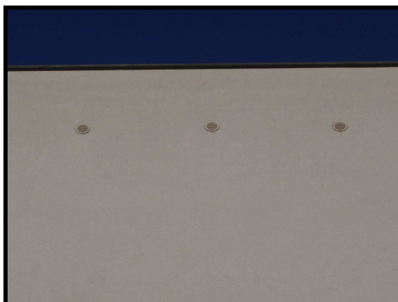
Nevhodná úprava po zateplení, kdy jsou VP opatřeny mřížkami různých typů
