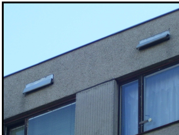
Stejný princip, uplatněný v minulosti na dosud nezatepleném objektu (Nešporova 573-575)
