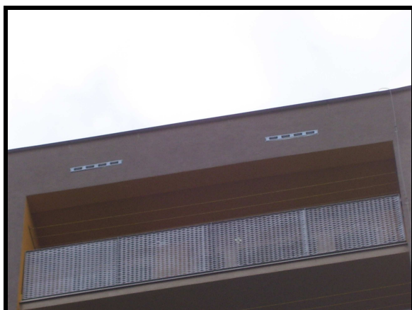
Nevhodná úprava po zateplení, kdy jsou VP opatřeny mřížkami různých typů
