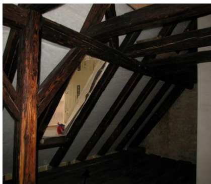
oprava střešní konstrukce - krov
