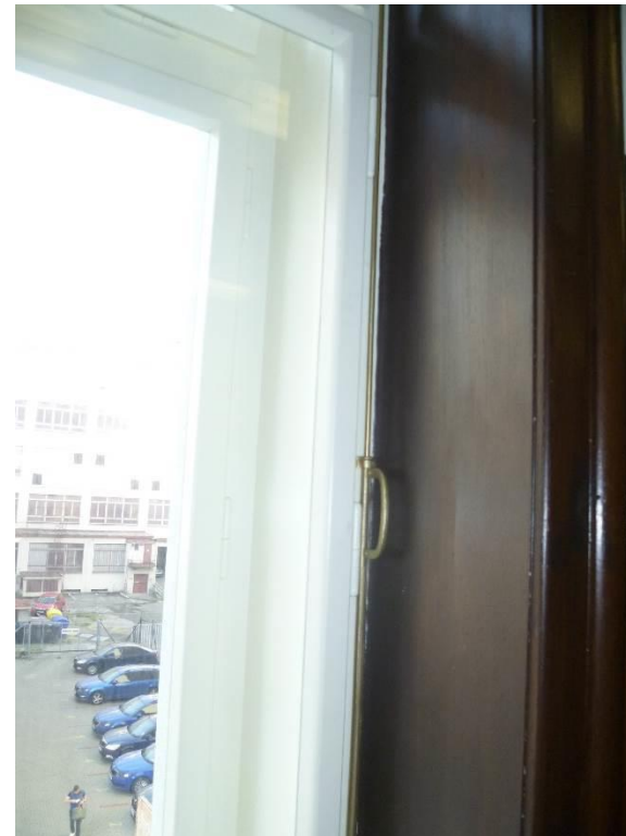
Táhlo po opravě - repasi
