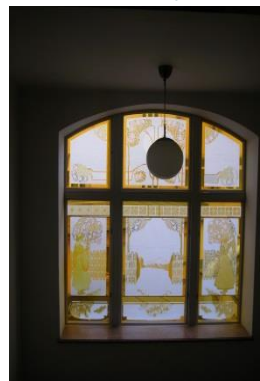
leptaná skla – doplnění původních novými
