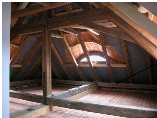
oprava střešní konstrukce - krov
