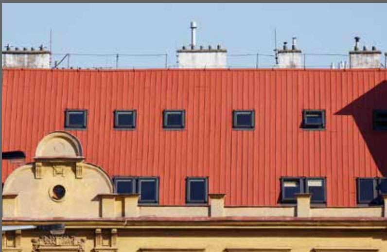
Původní keramická krytina nahrazena krytinou plechovou
