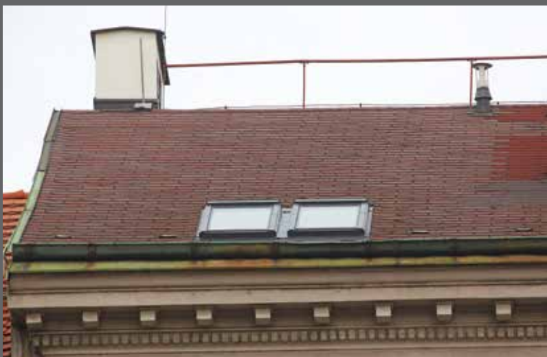
Původní keramická krytina nahrazena střešním asfaltovým šindelem
