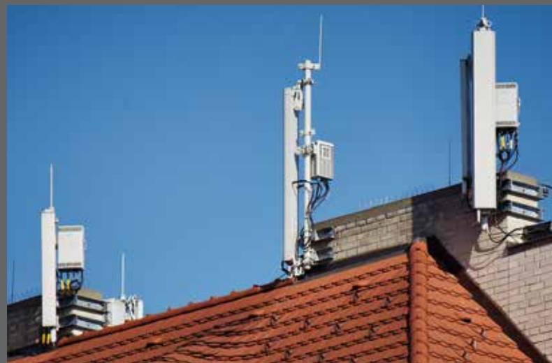
Antény mobilního operátora na komínovém tělese
