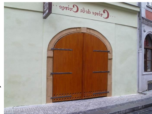
detail restaurování vstupních vrat – kovářské práce
