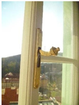
Detail zrepasované kličky u okna a dveří
