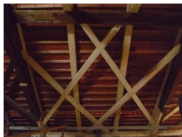
oprava střešní konstrukce - krov
