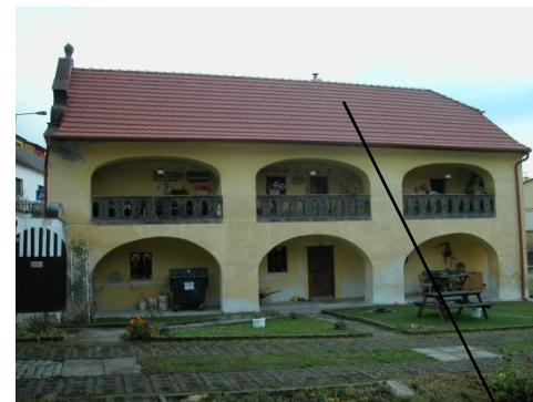
nová střešní krytina
