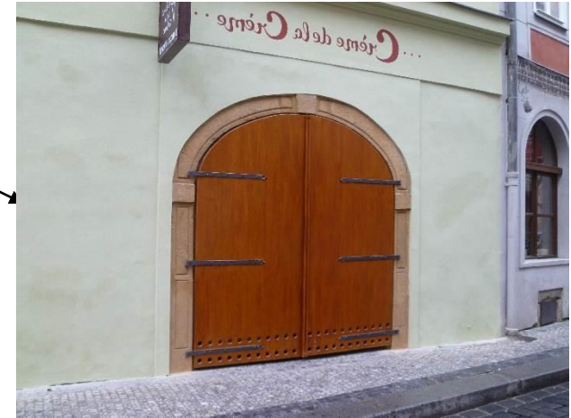
detail restaurování vstupních vrat – kovářské práce
