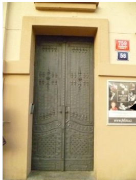
restaurování vstupních vrat
