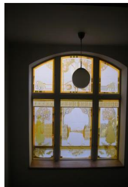
leptaná skla – doplnění původních novými
