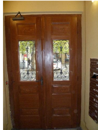
detail restaurování vstupních vrat
