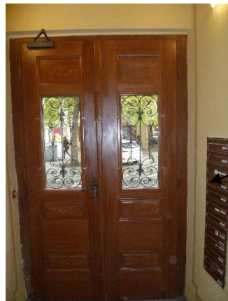
detail restaurování vstupních vrat
