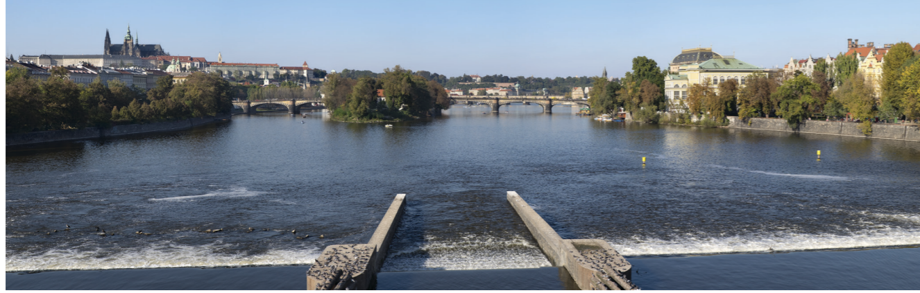
5.10 POHLED Z JIRÁSKOVA MOSTU PO PROUDU
