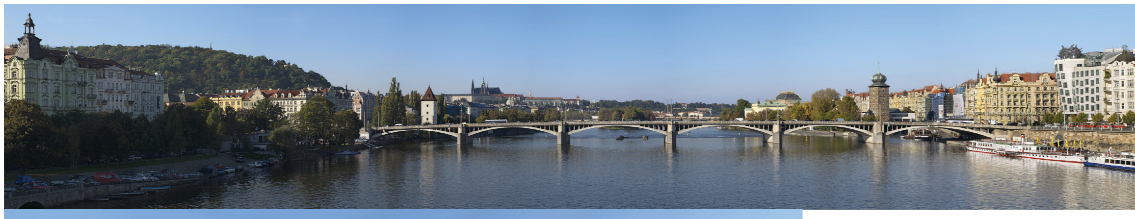
5.11 POHLED Z PALACKÉHO MOSTU PO PROUDU
